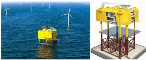
Figura 20 - stazione HVDC di trasformazione e conversione 66/500 kV AC/DC
