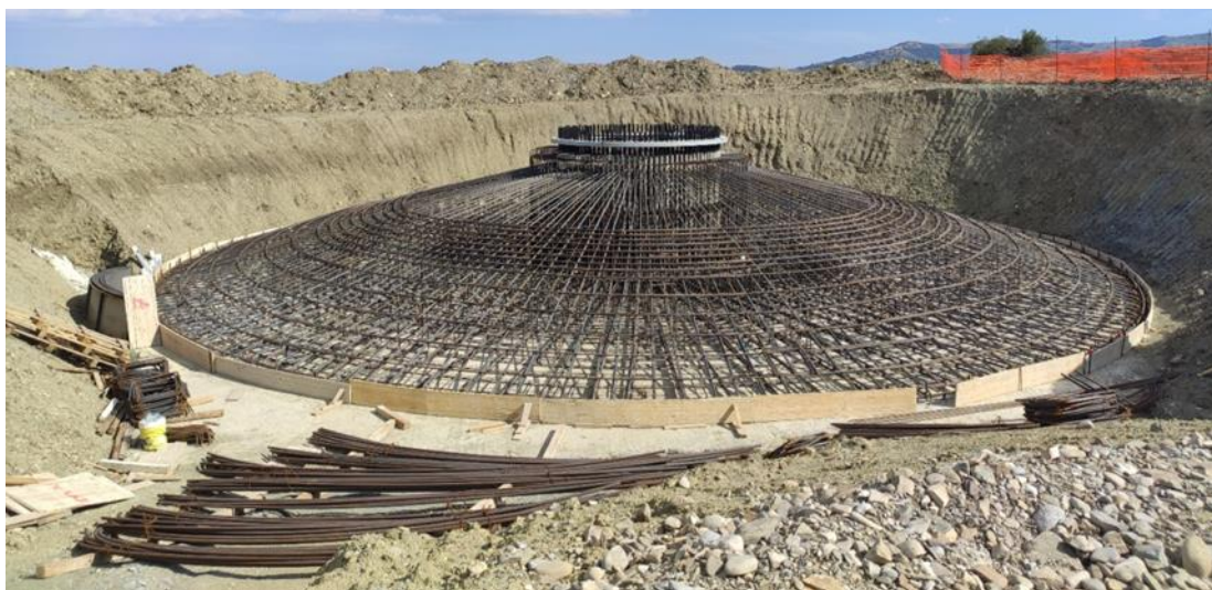
Figura 5-4: immagine tipo armature plinto
