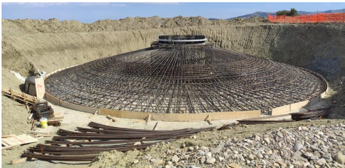
Figura 4-4: immagine tipo armature plinto
