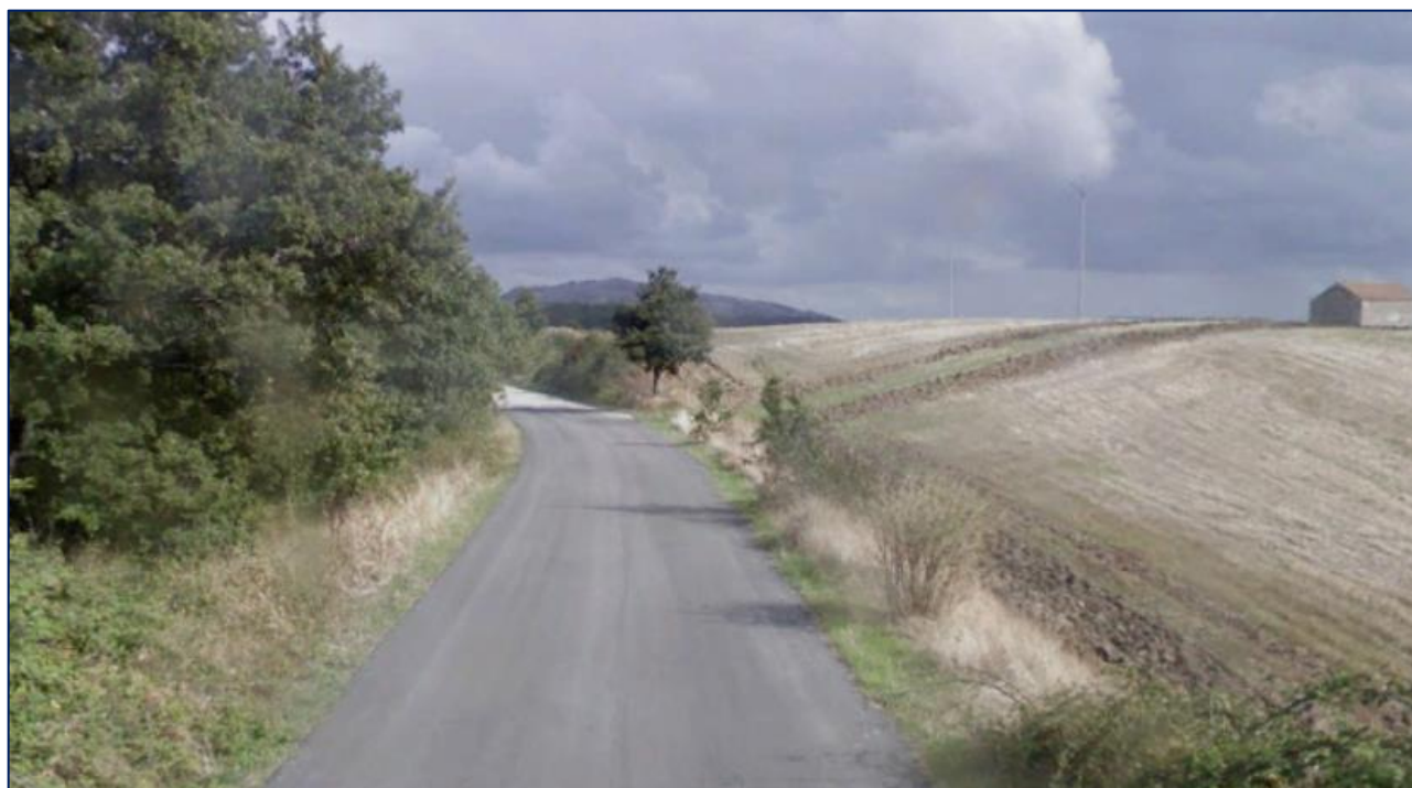
Figura 5-13: Viabilità locale nei pressi nella WTG3
