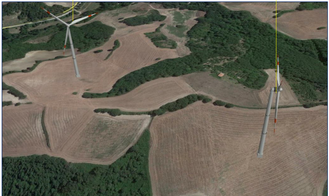
Figura 5-25: terreno di ubicazione della WTG10 e WTG11
