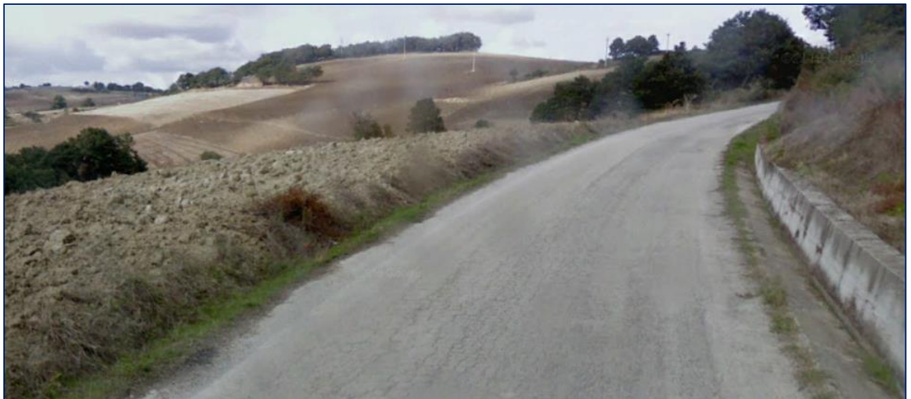
Figura 5-21: Viabilità locale nei pressi della WTG6, WTG8 e WTG9
