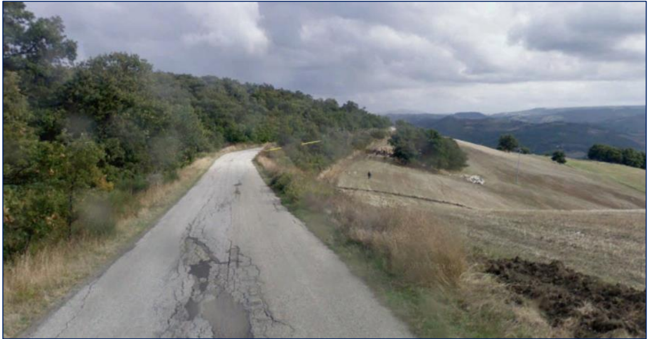
Figura 5-10: Viabilità locale nei pressi nella WTG2
