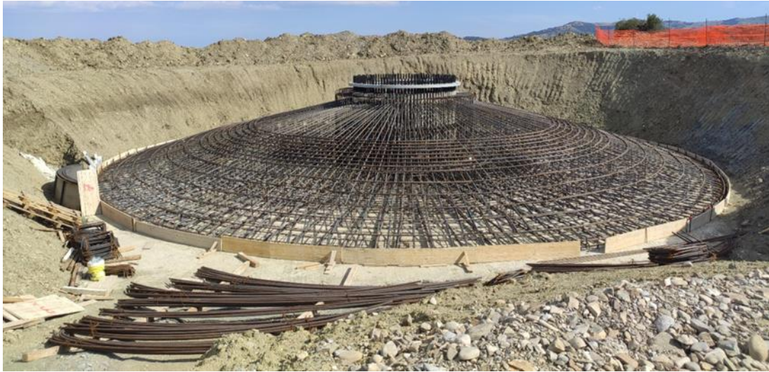
Figura 3-6: immagine tipo armature plinto
