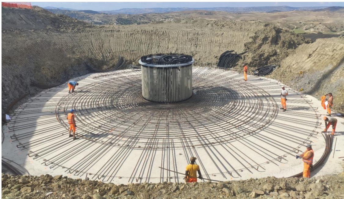
Figura 3-5: immagine tipo posa anchor cages
