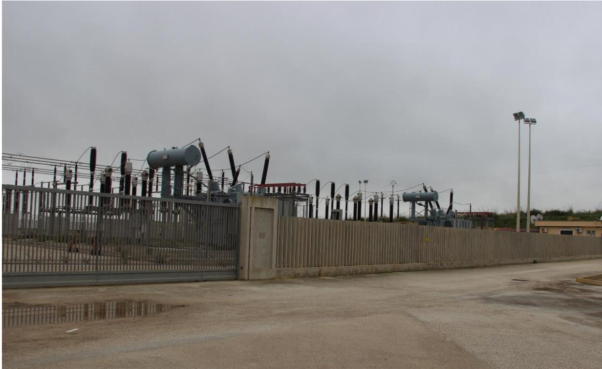
**Figura 13 – Stazione Elettrica SE RTN “Sambuca” all’interno della quale è prevista la realizzazione dello stallo arrivo cavo AT**
