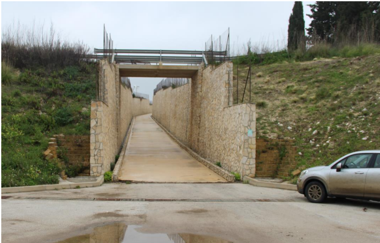
Figura 15 – Strada a servizio della Stazione Elettrica SE RTN “Sambuca” lungo la quale è prevista la posa del cavo AT
