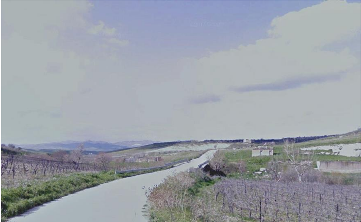
Figura 11 – Viabilità locale interessata dal tracciato del cavidotto in corrispondenza dell’attraversamento sul torrente Senora
