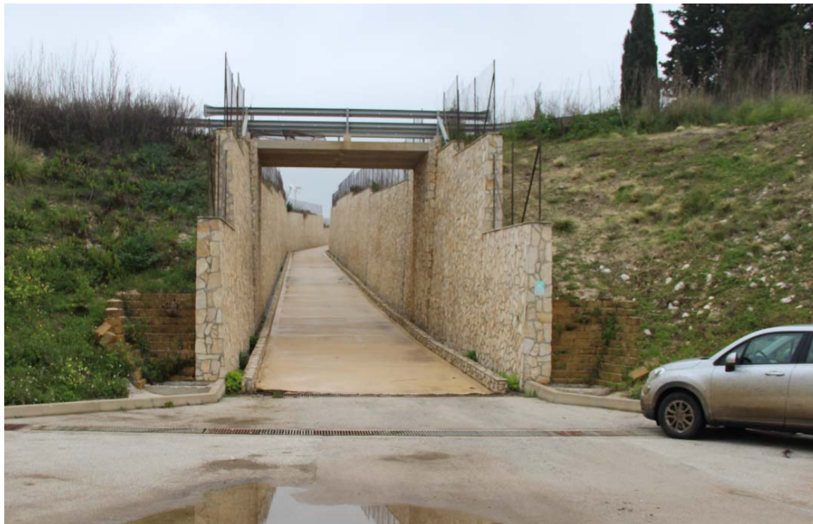
Figura 15 - Strada a servizio della Stazione Elettrica SE RTN "Sambuca" lungo la quale è prevista la posa del cavo AT
