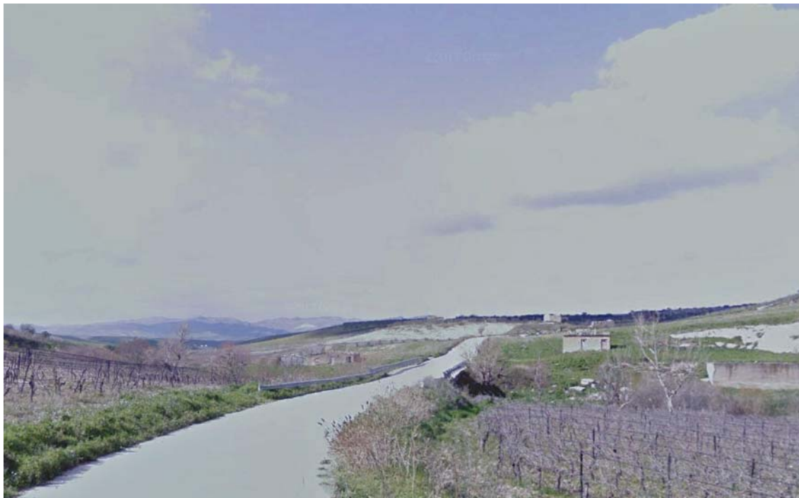
Figura 11 - Viabilità locale interessata dal cavidotto in corrispondenza dell'attraversamento del torrente Senore
