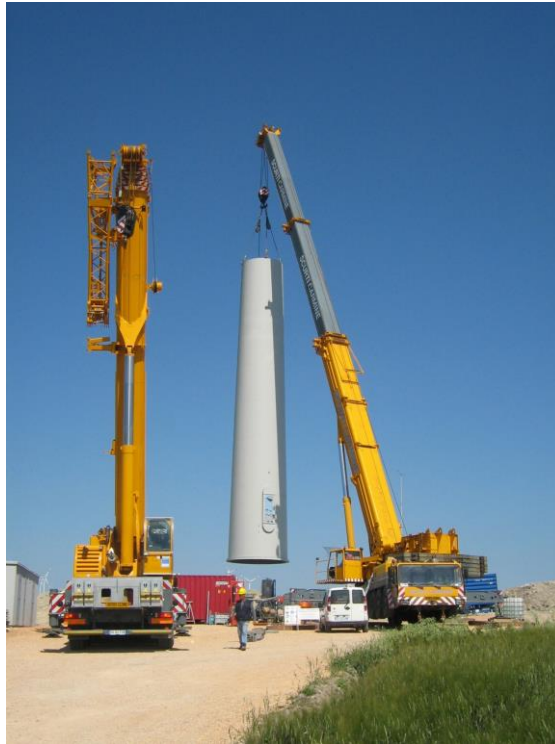
Figura 5: elemento torre smontata da trasportare
