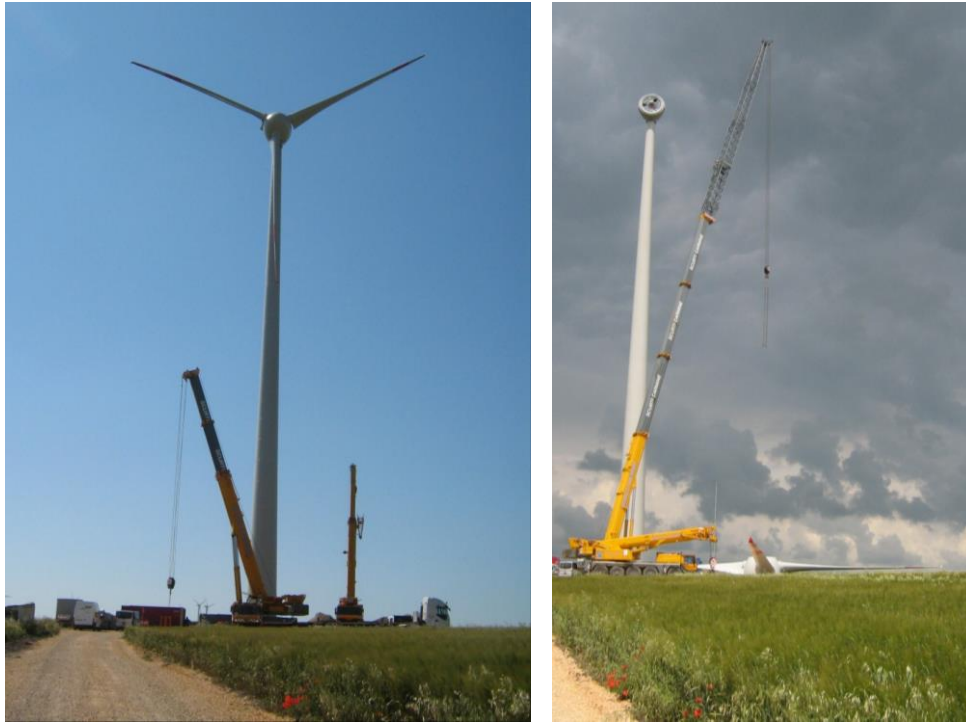
Figura 2: rimozione eliche e mozzo
