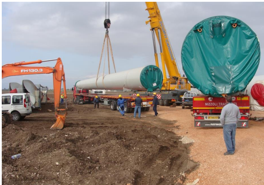
Figura 6: elementi torre smontata da trasportare
