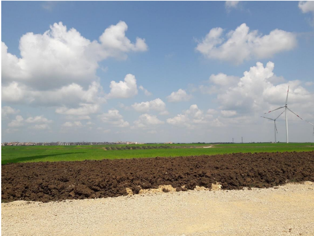
Figura 16: ripristino ante operam di alcune aree attraverso la posa di terreno vegetale
