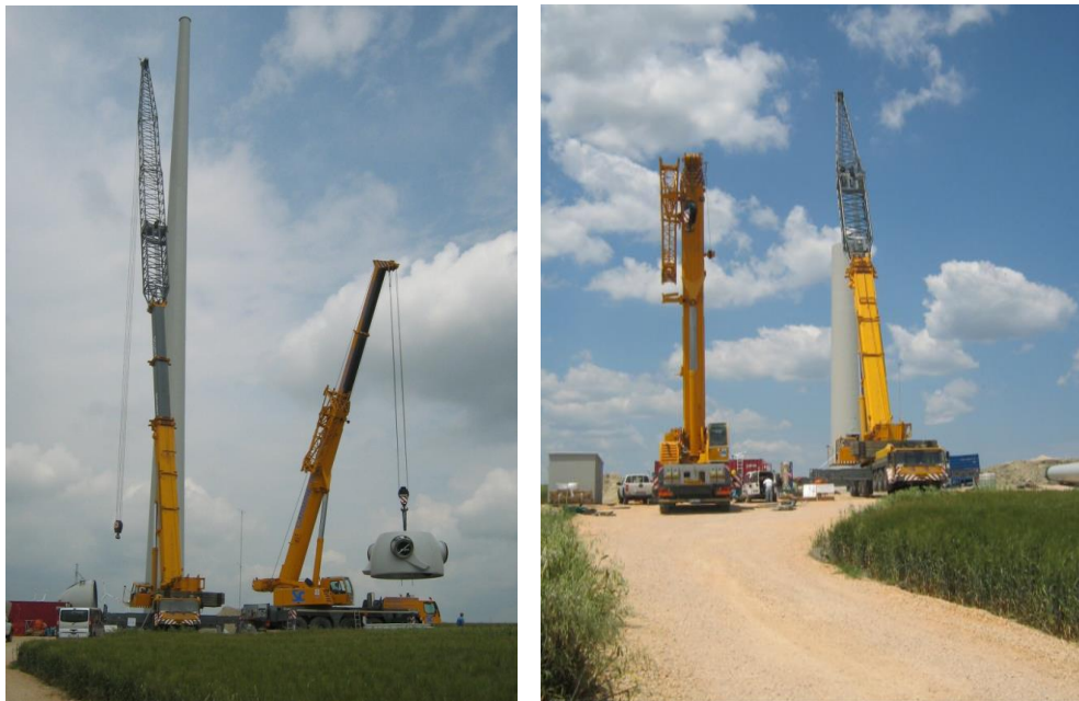
Figura 3: smontaggio navicella
