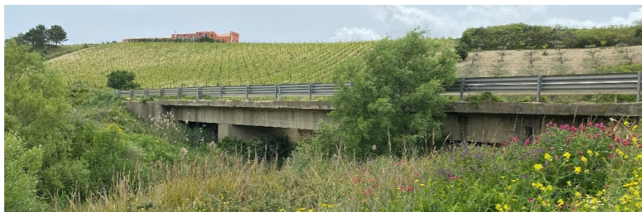
Figura 2 – Attraversamento del Torrente Senore in corrispondenza della strada comunale all'altezza dello svincolo Crivello della SS624
