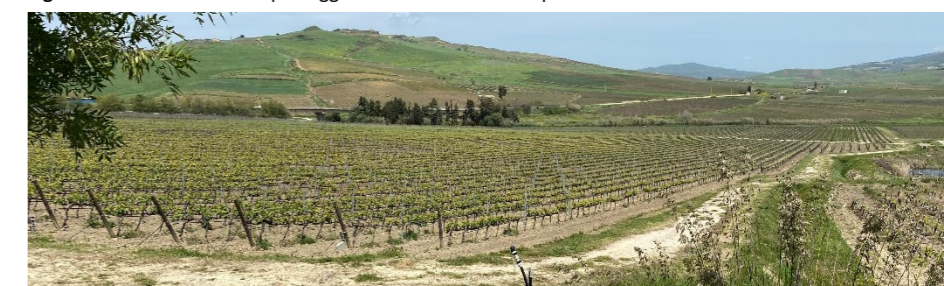
Figura 7 – Strada vicinale di passaggio del cavo esterno MT parallela alla SS624.
