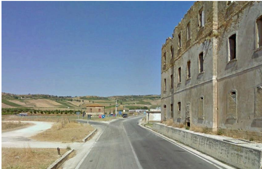
Figura 7 – Tratto della SP70 in prossimità dello svincolo della SS624 interessato dal tracciato del cavidotto
