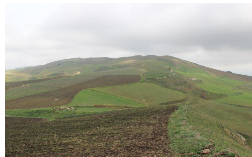
Figura 5 – Sito installazione aerogeneratore T02-T01
