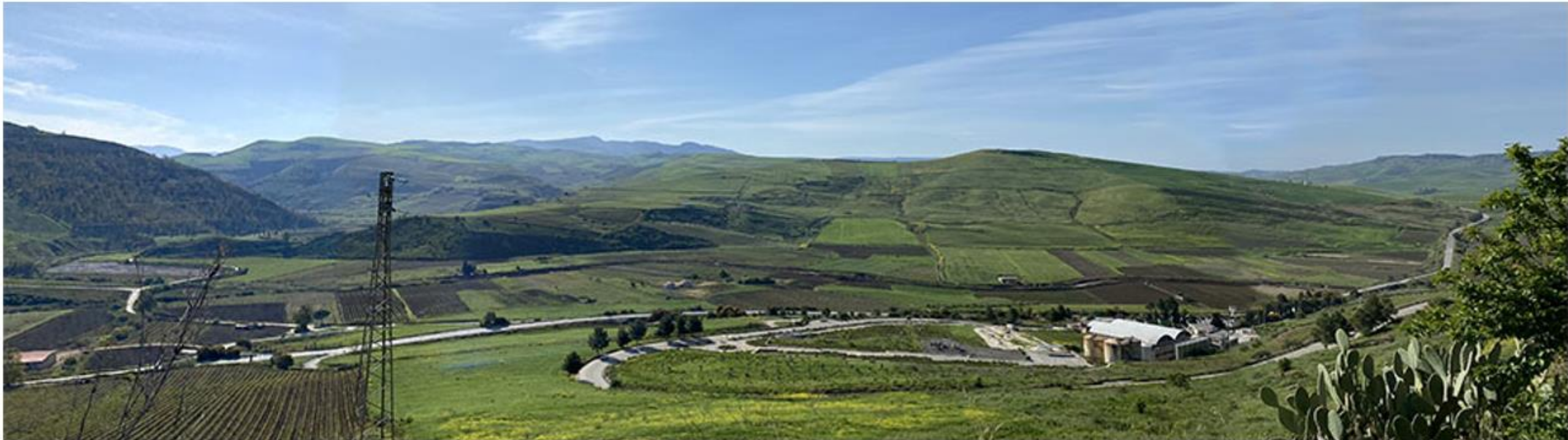
Panoramica dal centro abitato di Poggioreale, Via Sardegna- STATO DEI LUOGHI
