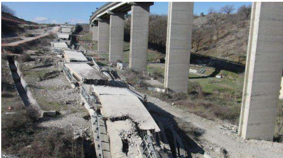
Esempio di viadotto demolito con micro-cariche
