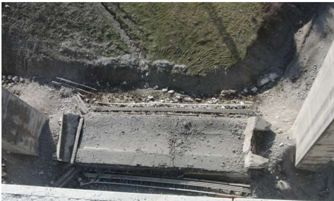
Esempio di viadotto demolito con micro-cariche
