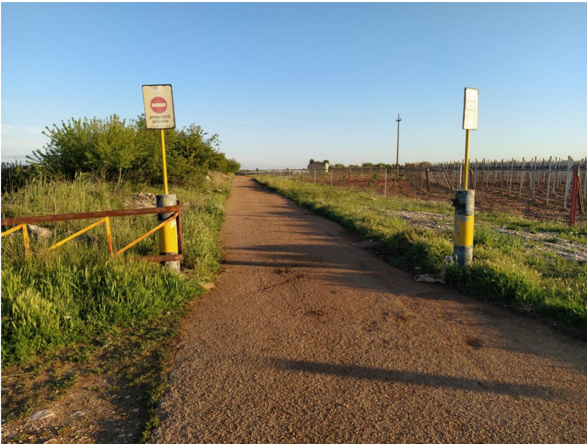
Viabilità di servizio privata di AQP per la manutenzione del sottostante acquedotto erroneamente inclusa tra la viabilità del progetto eolico
