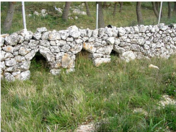
Muretti a secco con aperture per il deflusso delle acque
