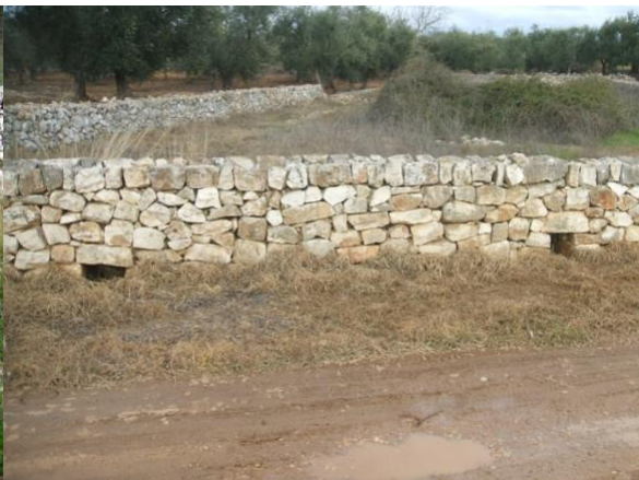
Terrapieno parzialmente crollato a causa dell'azione dell'acqua nell'area dell'impianto eolico
