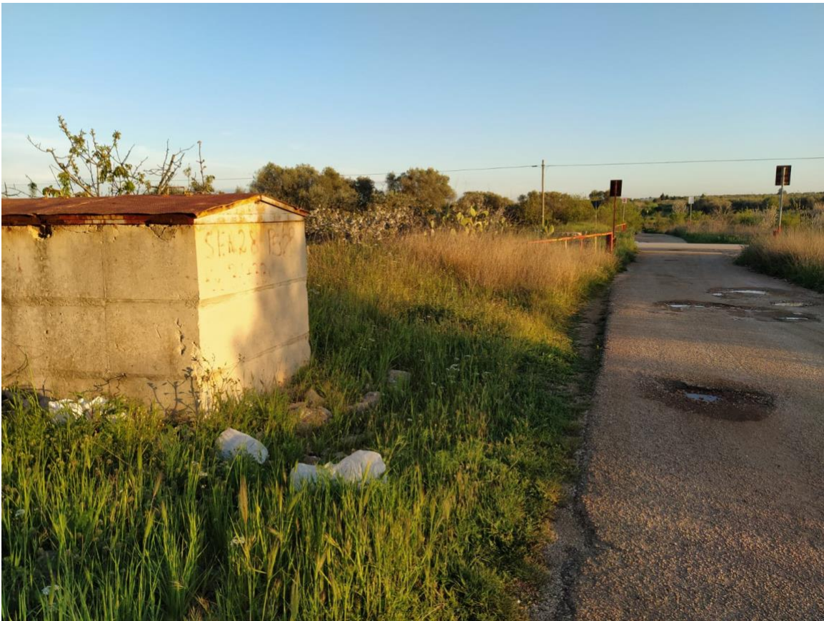
Un altro tratto della viabilità di servizio privata di AQP con una cabina tecnica dell'acquedotto
