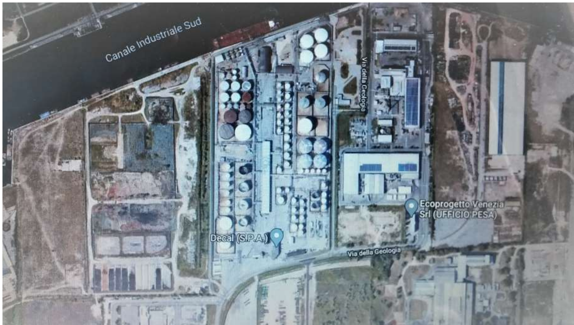
FOTO CANTIERE VENICE LNG SpA – Porto Marghera (VE)
