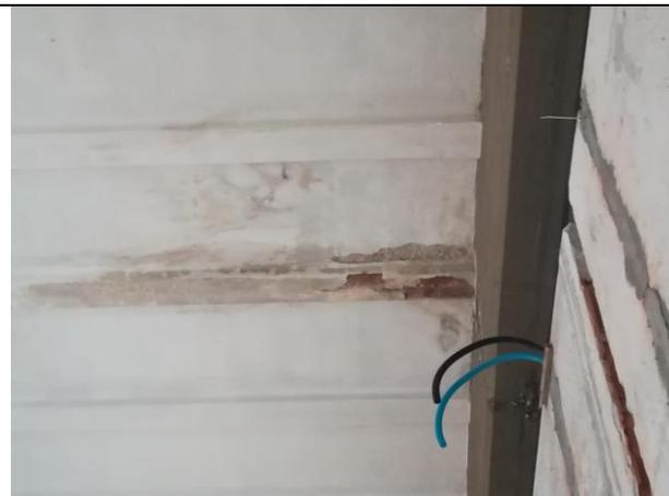
**Foto 3:** Particolare intradosso solaio di copertura del fabbricato in corrispondenza delle infiltrazioni d'acqua
