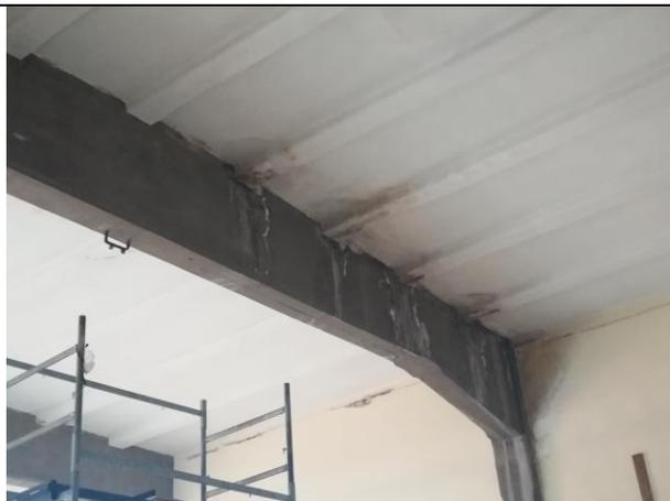
**Foto 2:** Presenza di infiltrazioni all'interno del fabbricato in corrispondenza della
