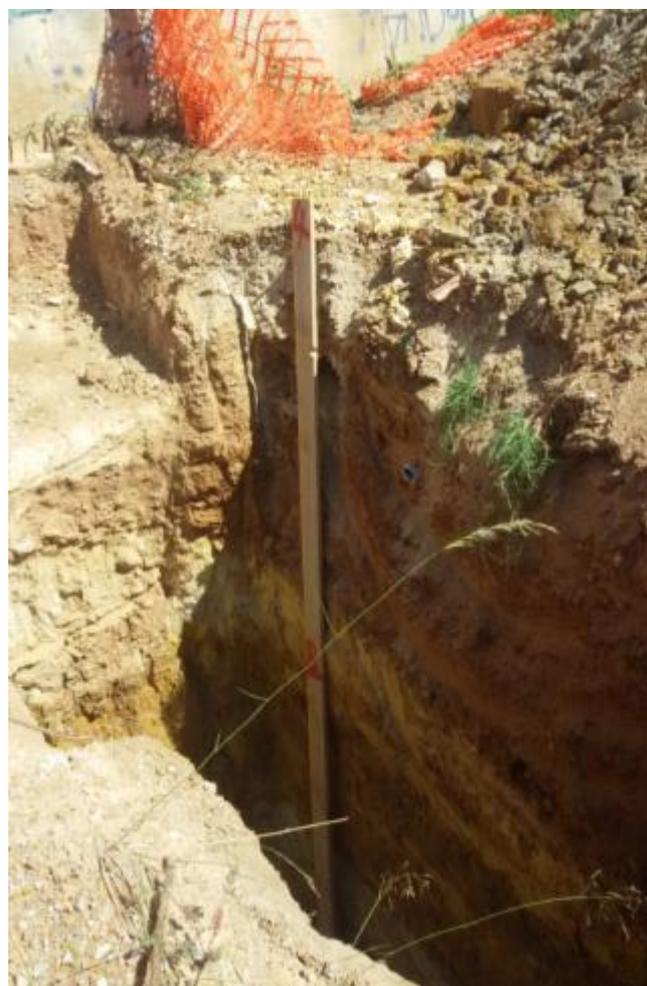
Figura 12 – Scavo a profondità 4 m in corrispondenza del sondaggio S4 per verifica presenza di falda (Luglio 2020)
