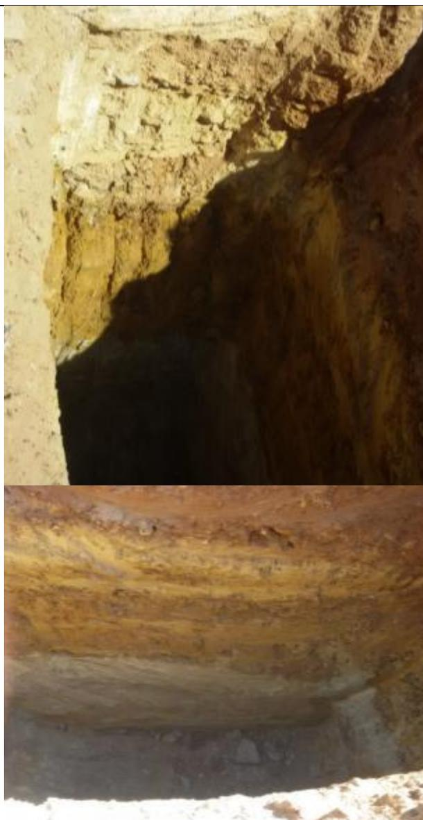
Figure 11 – Scavo a profondità 4 m in corrispondenza del sondaggio S4 per verifica presenza di falda (Luglio 2020)
