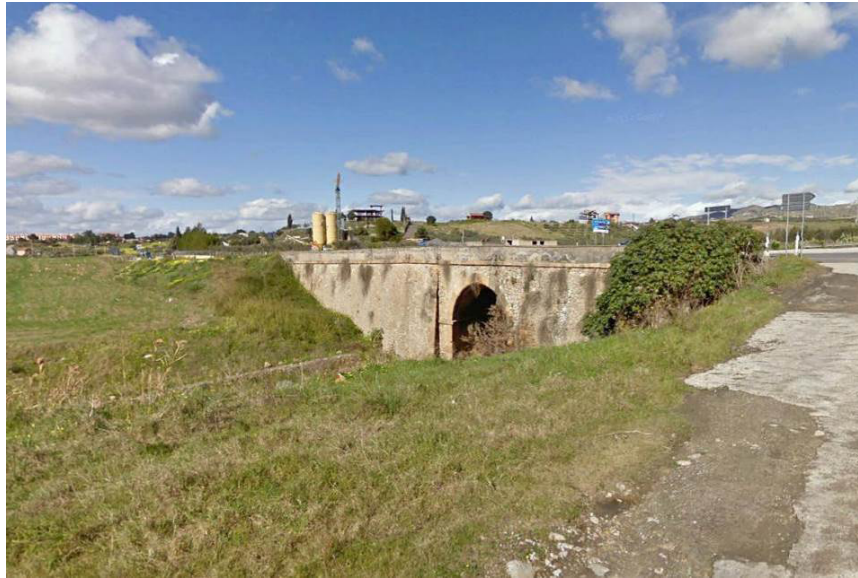
Figura 17: Vallone della Rosa - Foto attraversamento SS192
