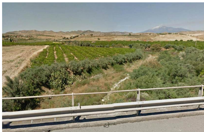
Figura 19: Vallone della Rosa - Foto da ponte autostradale
