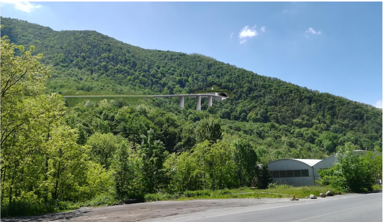
Vista dell'Imbocco Nord (lato Lumezzane) della galleria naturale Villa Carcina con relativi manufatti tecnici.
