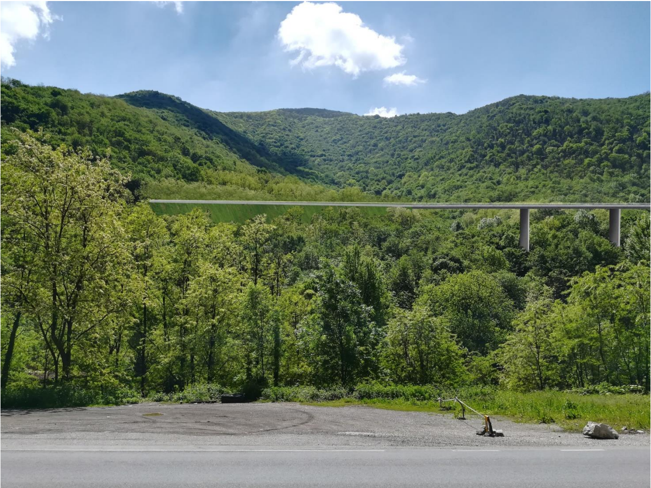
Vista del viadotto B del tratto stradale della Valgobbia.
