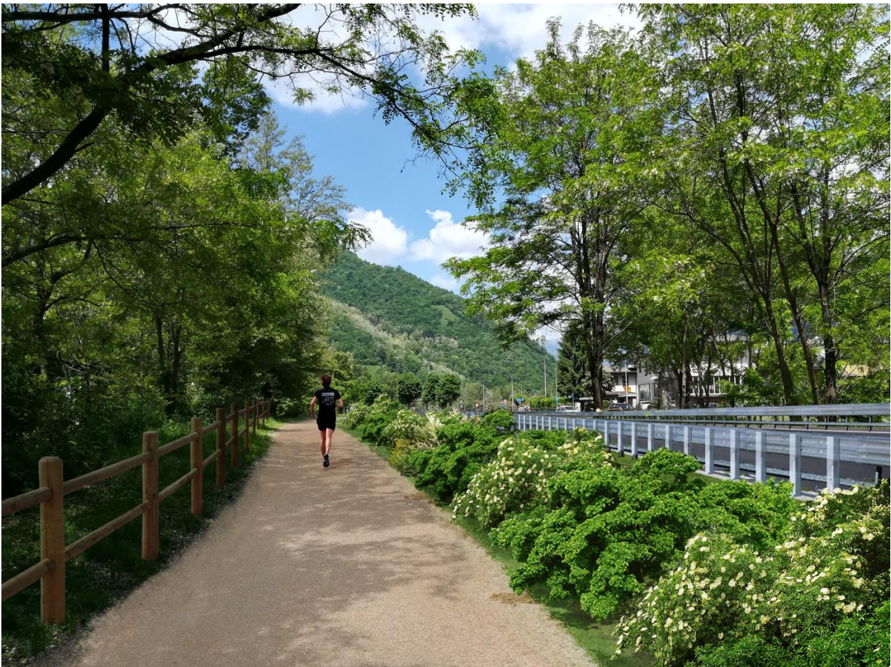
Vista del tratto stradale di Sarezzo adiacente alla pista ciclabile esistente.
