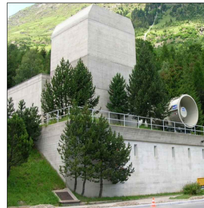
ESEMPIO DI MANUFATTO_Autostrada N2, Galleria stradale del San Gottardo, Ampliamento centrale di ventilazione Airole, 2005
