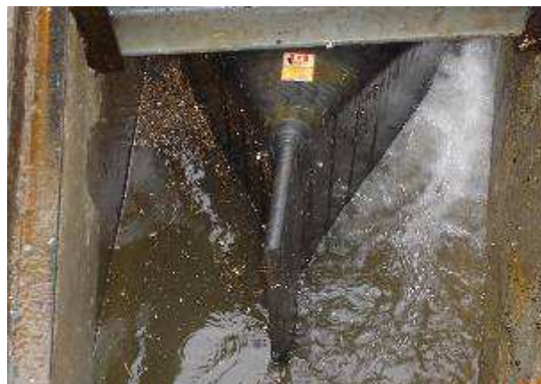
Applicazione scarico in pozzetto
