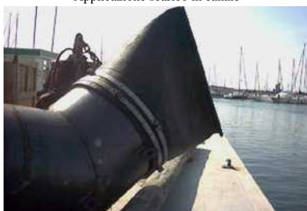
Preparazione scarico a mare prima dell'installazione
