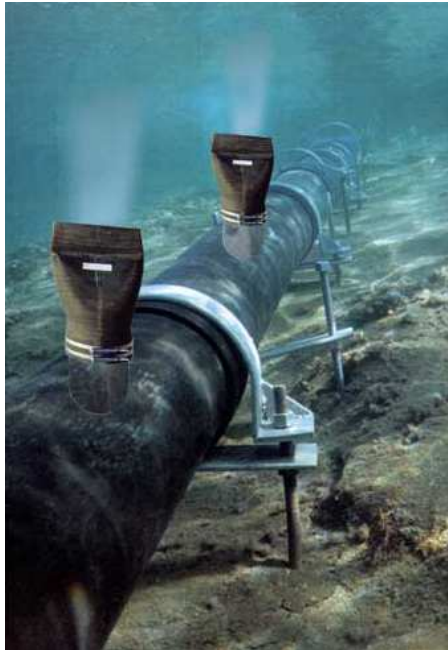
Applicazione su condotta sottomarina
