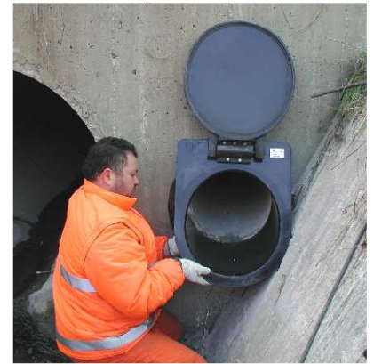
MULTI NB applicazione a muro o su flangia DN 200 – 600mm
