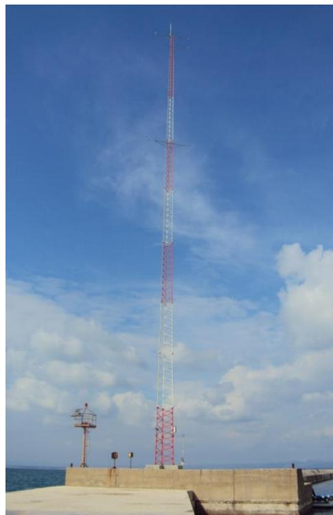
**Figura 1: Esempio di torre anemometrica**
