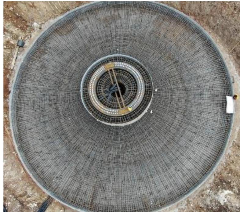
Figura 1: Vista dall'alto dell'armatura del plinto di fondazione di un aerogeneratore in fase di esecuzione e montaggio.
