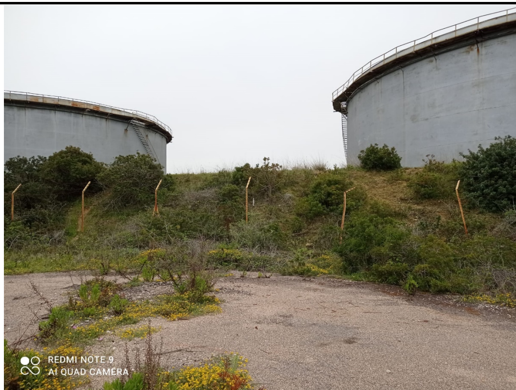
Figura 4.6 Foto 1 Piazzolarea Torre Anemometrica
