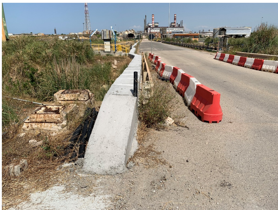
Figura 7 – Vista della canaletta in c.a.v. fuori terra presente sul ponte
