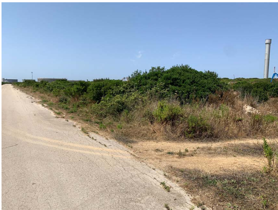
Figura 8 – Vista verso nord-ovest della strada nel punto E
