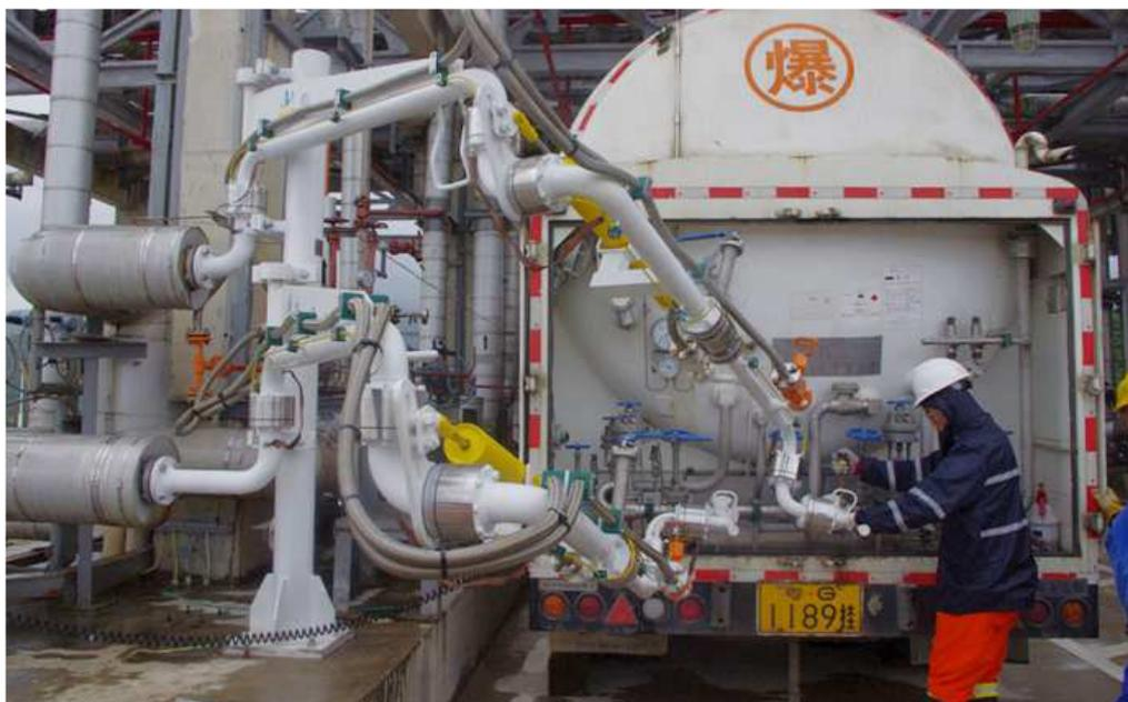
**Fig. 6.3 - esempi di bracci di carico per il riempimento delle autocisterne/isocontainer.**
