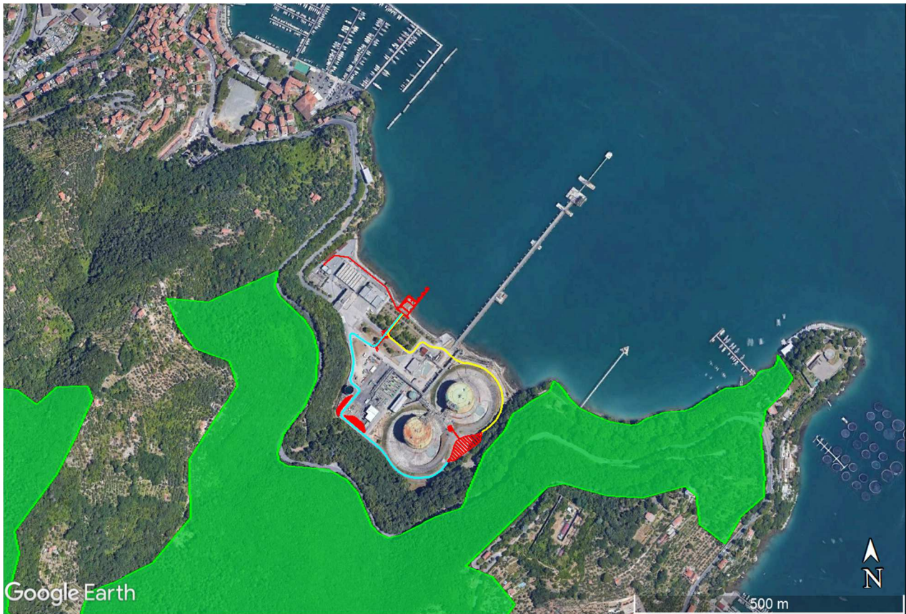
Figura 1: terminale di Panigaglia e localizzazione delle opere in rosso. Le linee azzurre e gialle indicano i percorsi delle autocisterne/isocontainer all'interno del Terminale; in blu il Sito della ZSC "Portovenere – Riomaggiore – S. Benedetto" (in verde) (Fonte Google earth)
