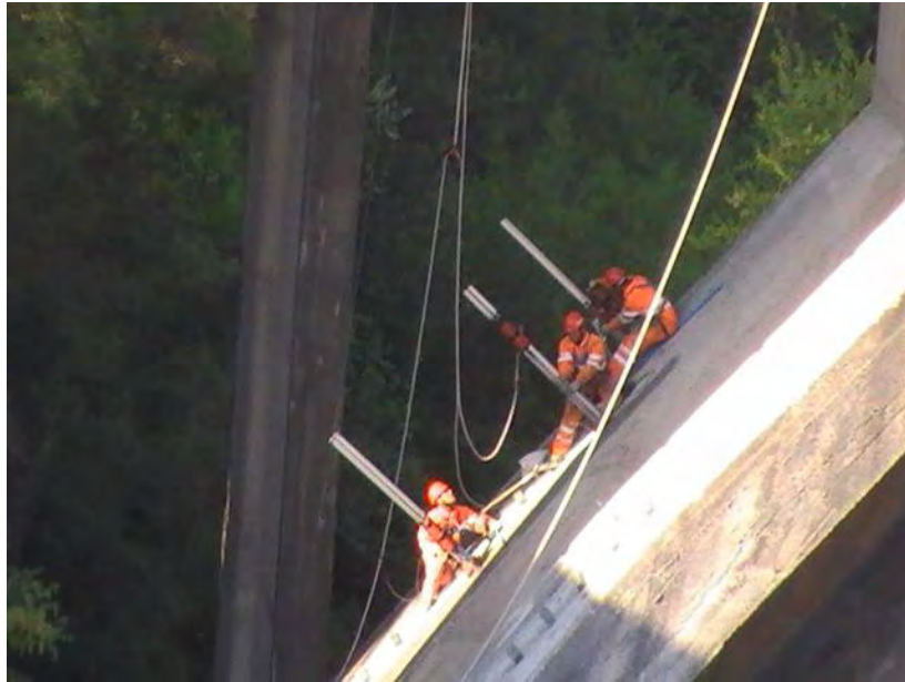
Perforazione a carotaggio
