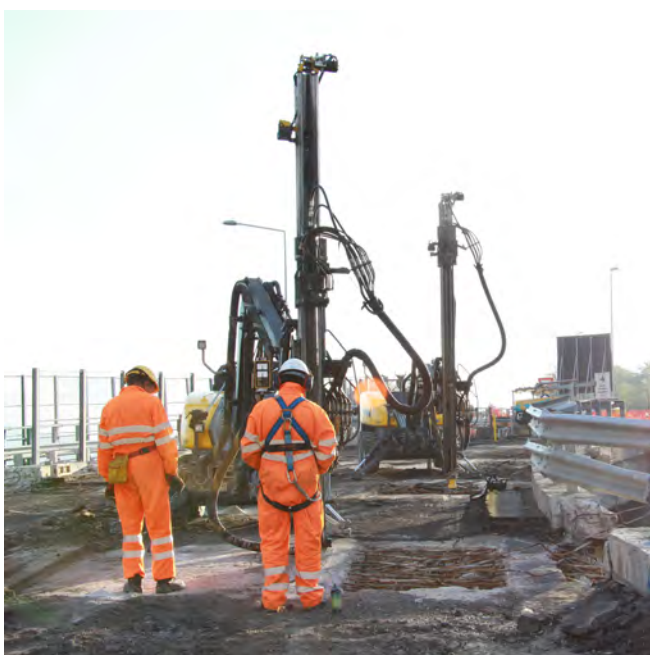
Perforazione dei fori da mina sulle travi degli impalcati.
