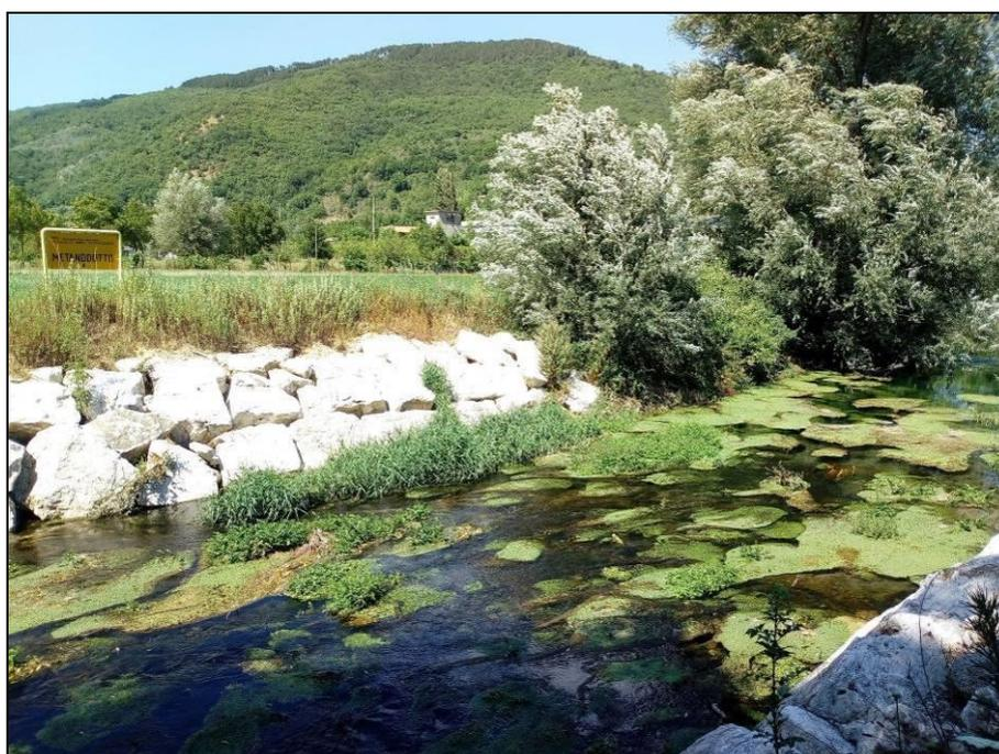
Figura 6.10: Fiume Velino attraversato dai lavori del 2017 con ripristino spondale in massicciata semplice al KP di progetto **125+600 circa**.
