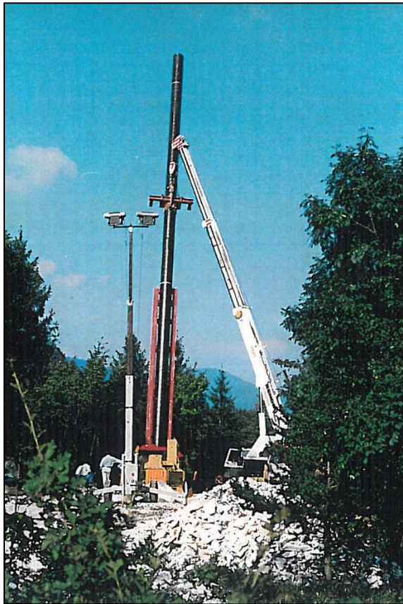
Fig. 2.14 - varo della condotta
