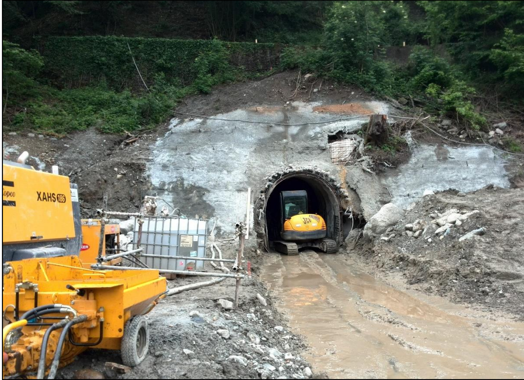
Fig. 2.11 - Galleria di base
