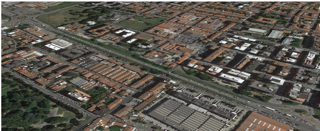
Immagine aerea del tratto di intervento
