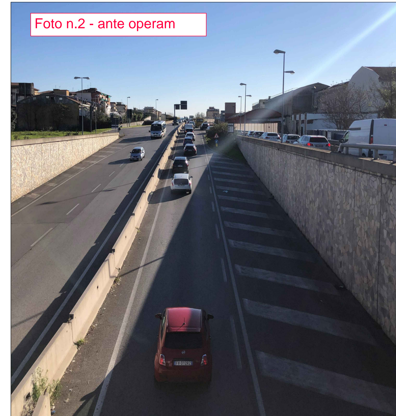
Foto n.2 il progetto di ampliamento ed interrimento con la vista dell'imbocco lato Pistoia, con il rivestimento fonoassorbente dei muri laterali e la barriera antirumore sulla rampa di uscita dalla galleria in direzione Viale Nenni
