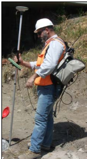
Figura 3-4- Strumentazione utilizzata per la georeferenziazione dei punti di sondaggio
