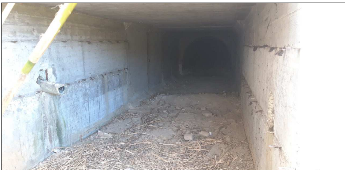
Figura 3 – Tombamento dismesso e tamponato della Gora Mazzoni
