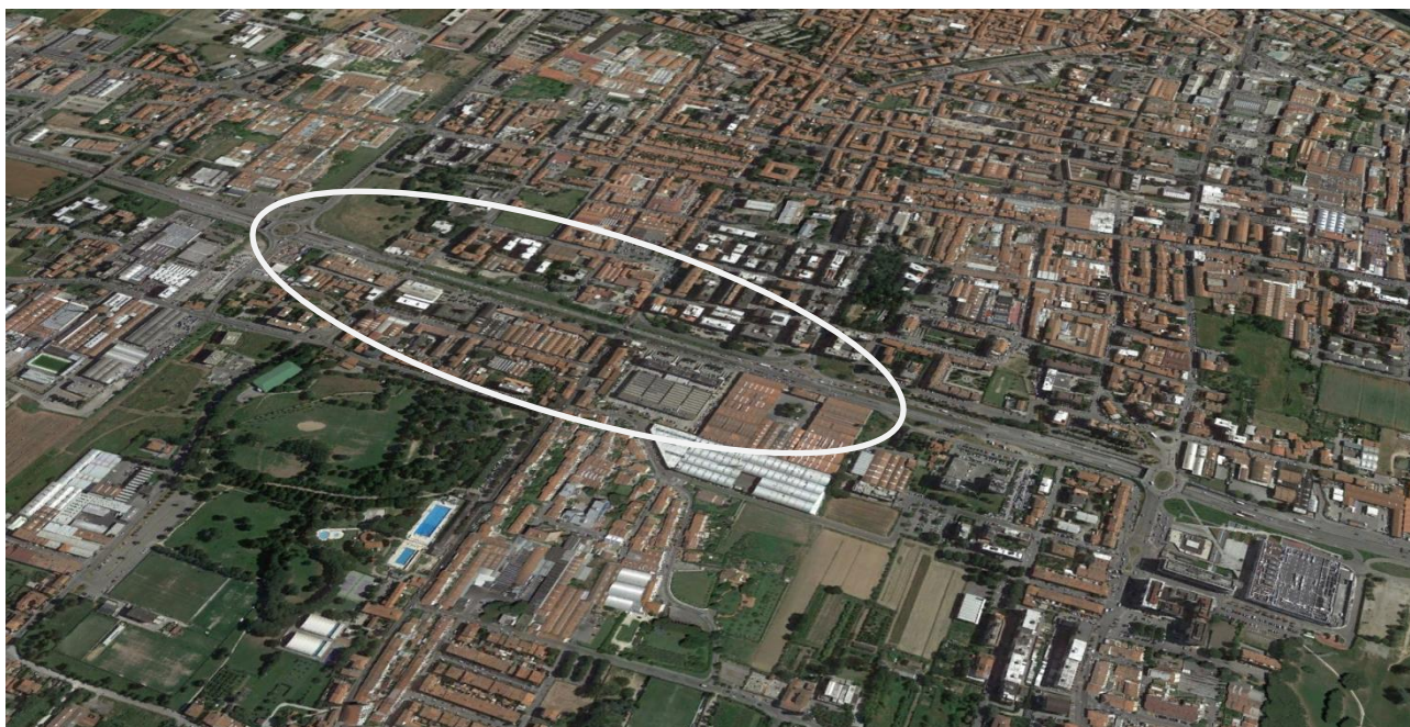
Figura 1 - Immagine aerea di via Leonardo Da Vinci con inquadramento del tratto di intervento
