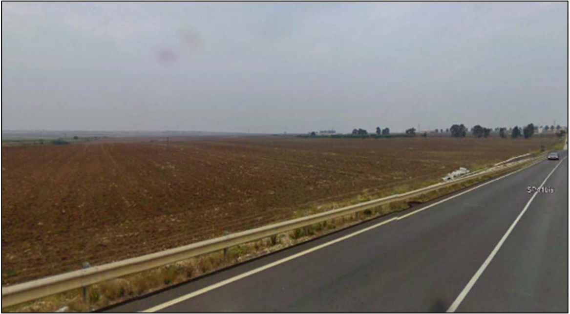
Veduta panoramica dalla A 14 – P6
