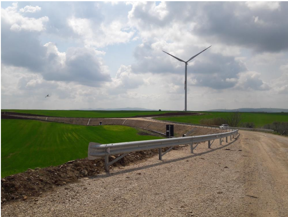
Impianto Eolico di proprietà nel Comune di Lavello (PZ) – Impianto in esercizio – terreni coltivati a grano, impianto stradale rimesso a nuovo, ripristino opere idrauliche.
