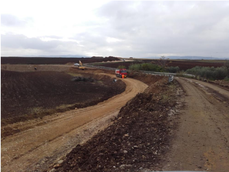
Impianto Eolico di proprietà nel Comune di Lavello (PZ) – Fase di cantiere – attività di ripristino stradale, ricostruzione ponte, sistemazione idraulica, pulizia terreni.
