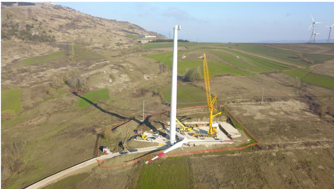
Impianto Eolico di proprietà nel Comune di Avigliano (PZ) – Impianto in costruzione – terreni acquistati e concessi in comodato gratuito agli agricoltori.
