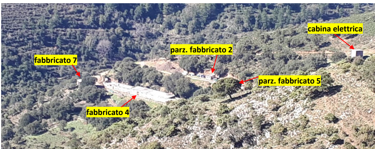
Immagine dello stato attuale dei luoghi 2021
