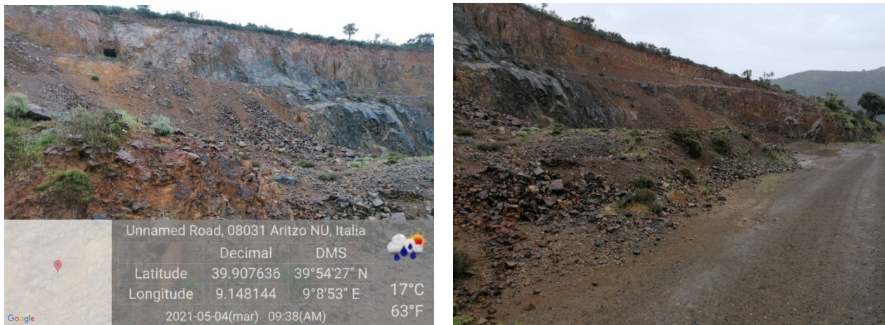
Fig. 2-3 : Cantiere di Perdabila
