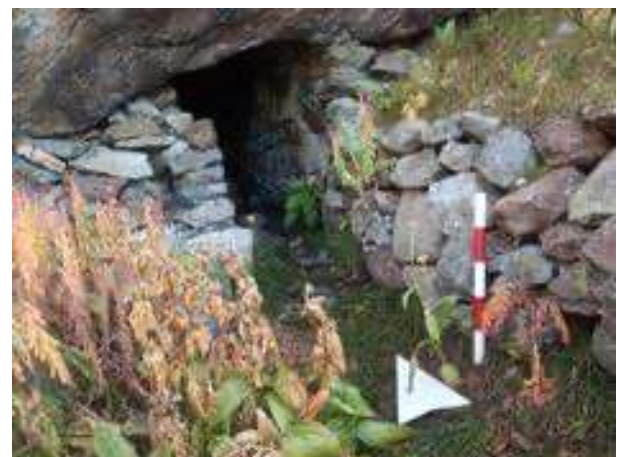
Figura 57. L'accesso all'ambiente interno del corpo B.
