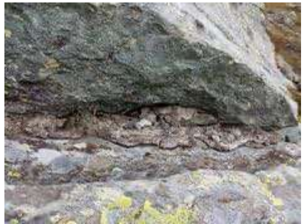
Figura 49. Residuo di malta all'interno di un solco di scolo dell'acqua.
