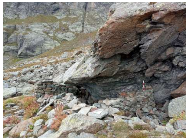
Figura 37. Lato sud-est del corpo A della casa dei minatori.
