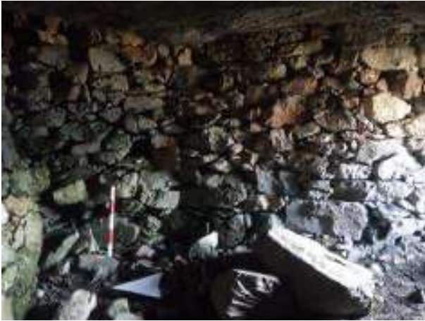
Figura 58. La parete est dell'ambiente interno del corpo B.
