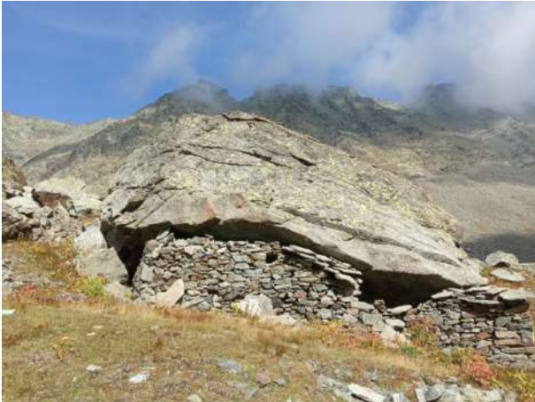
Figura 34. Lato ovest del corpo A della Casa dei minatori.
