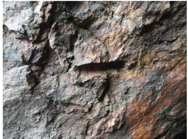
Figura 8. Cicatrice di foro da mina.
