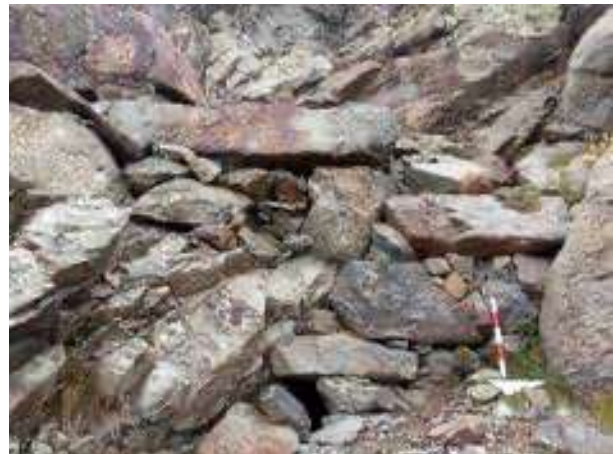
Figura 33. Porzione nord del muro (Struttura muraria 2).
