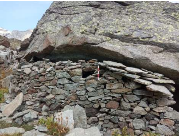
Figura 38. Muro ovest del corpo A della casa dei minatori. Dettaglio della finestra, del crollo e delle lastre spioventi.
