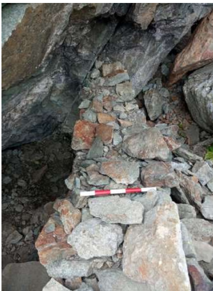
Figura 40. Muro tra il vano B e il vano C del corpo A della Casa dei minatori.
