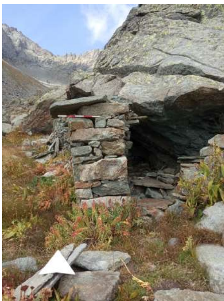
Figura 36. Ingresso del corpo A della casa dei minatori.
