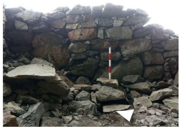
Figura 39. Lato interno del muro sud del corpo A della Casa dei minatori. È visibile la pietra con il foro.
