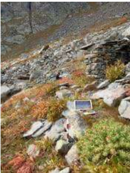
Figura 44. La struttura muraria di terrazzamento a sud-est del corpo A.
