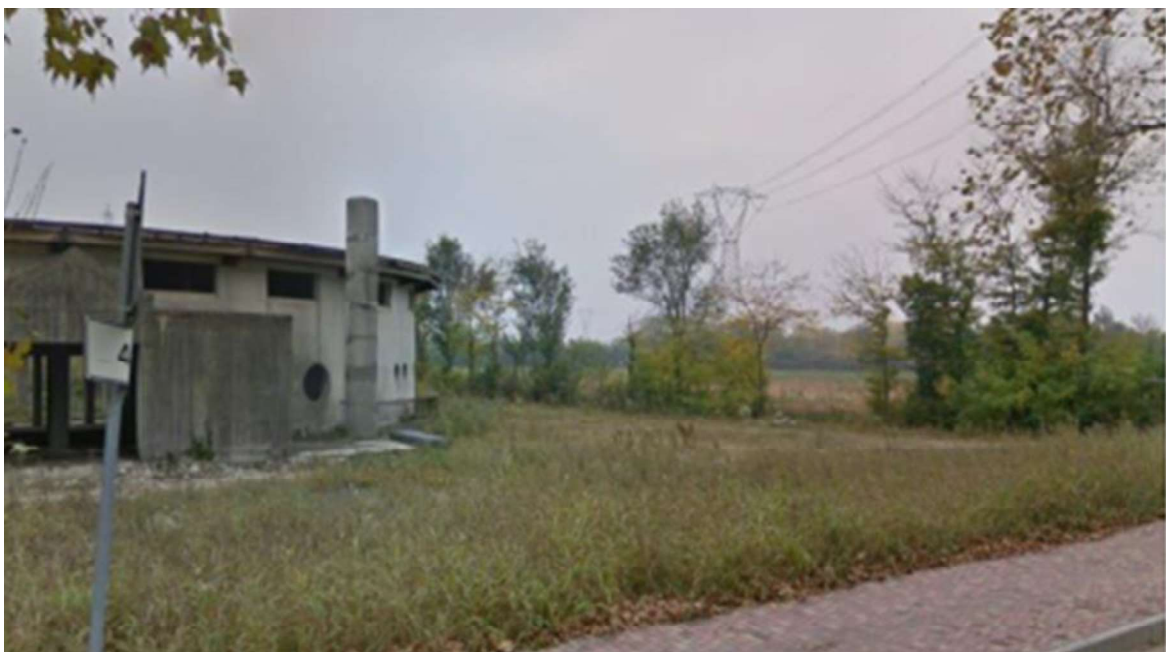
Montebelluna (TV) – Scuola in frazione Busta abbandonata a seguito della realizzazione dell'elettrodotto a 380kV
