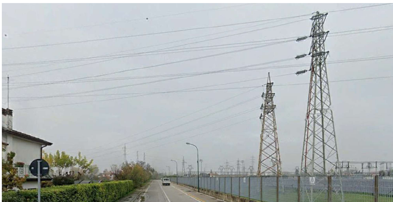
Stazione elettrica di Villa Bona Venezia Mestre
