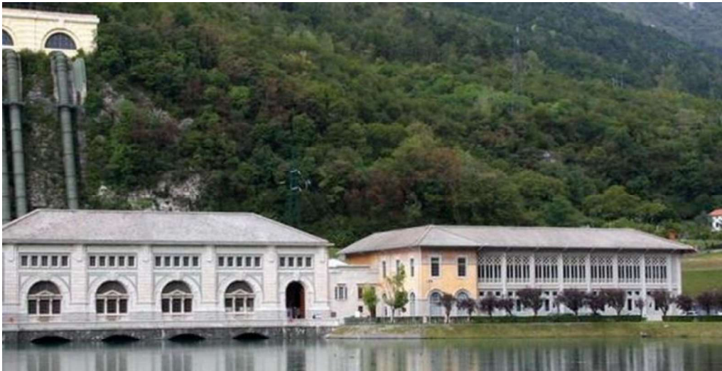
Vittorio Veneto (TV) – centrale elettrica Fadalto 1924
