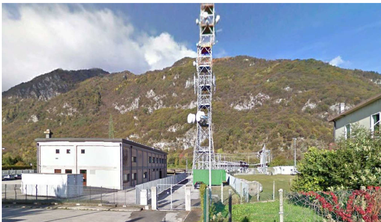
Stazione elettrica di Ponte nelle Alpi (BL)
