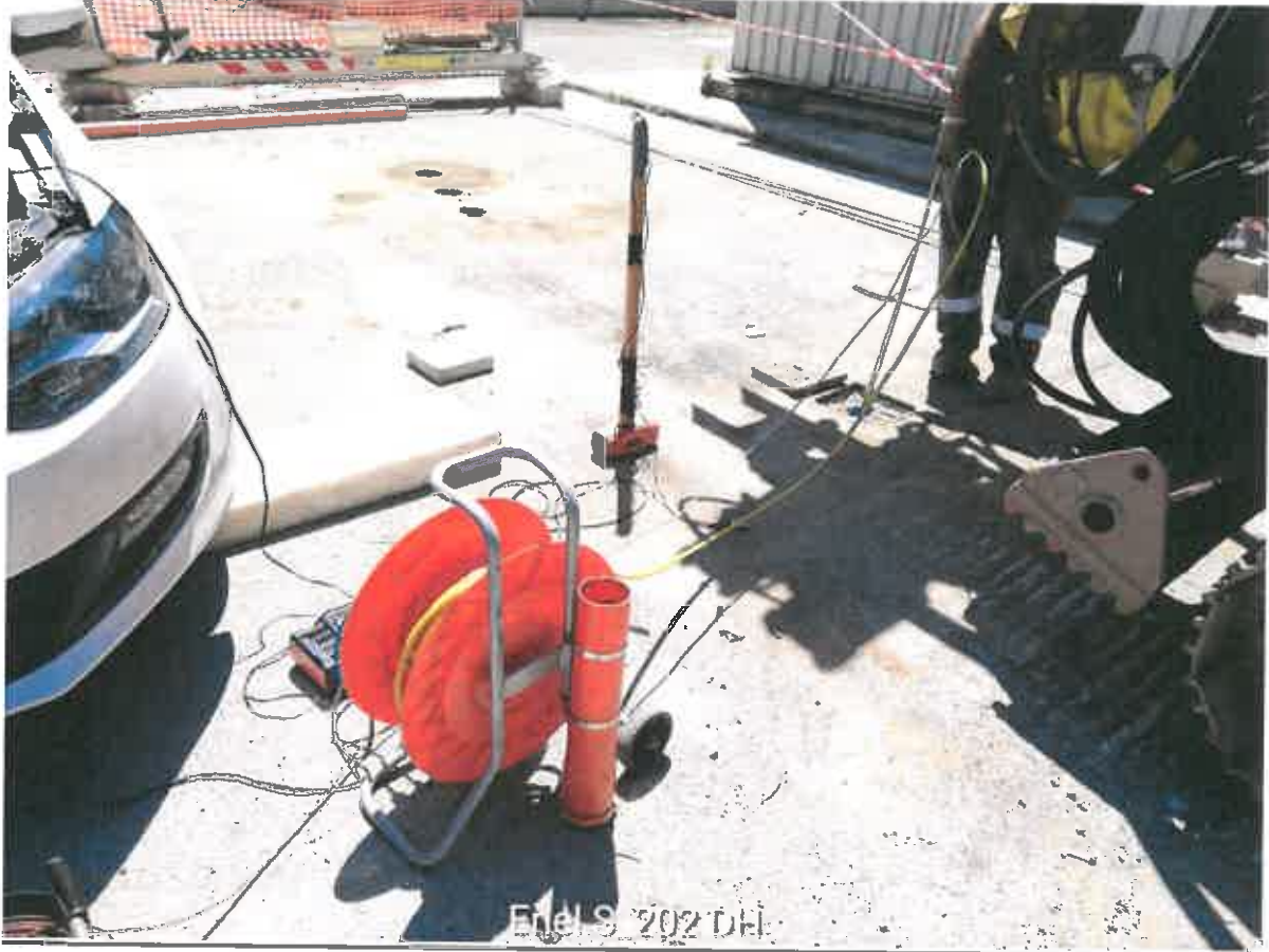
Foto 1 - Esecuzione della prova geofisica Down-Hole
