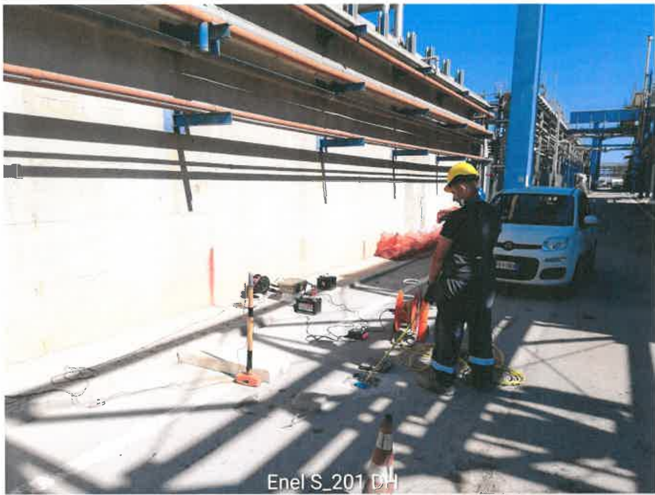
Foto 1 - Esecuzione della prova geofisica Down-Hole
