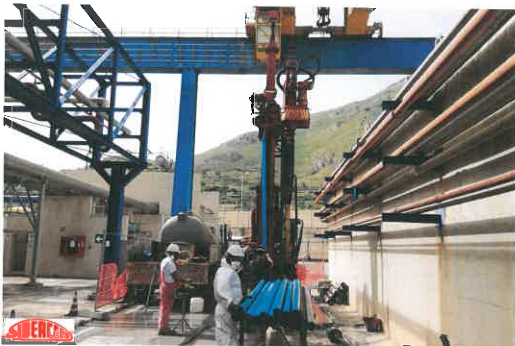
Figura 3.4.a: Installazione tubo per indagini geofisiche in foro
