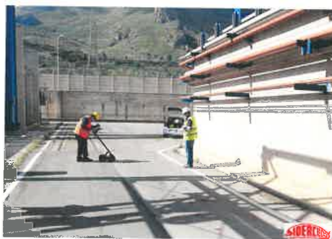
Figura 2.1.a: Ricerca sottoservizi - Georadar
