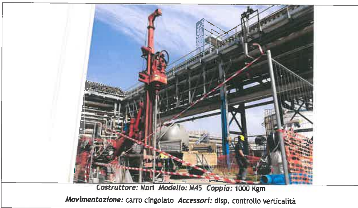
Figura 3.1.a: Impianto di perforazione utilizzato
