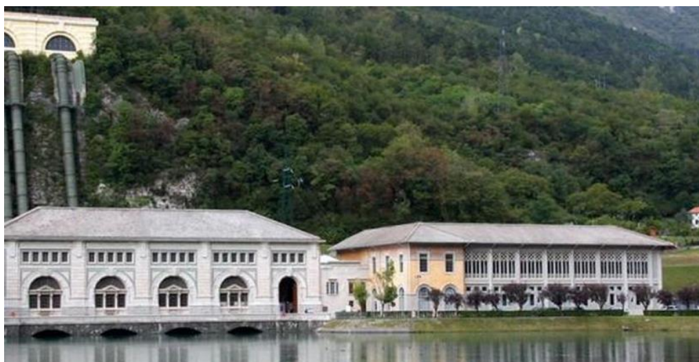
Vittorio Veneto (TV) – centrale elettrica Fadalto 1924
