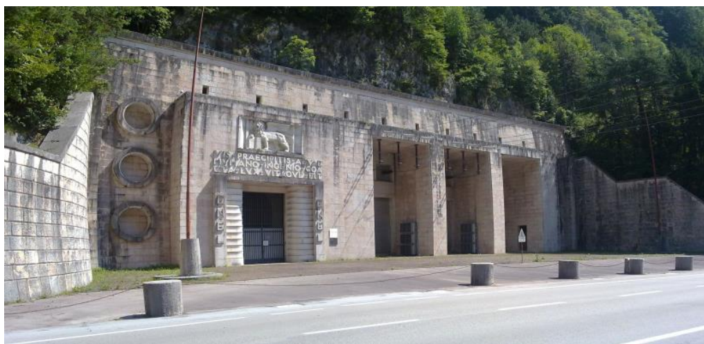
Sedico (BL) - Centrale elettrica la Stanga 1943
