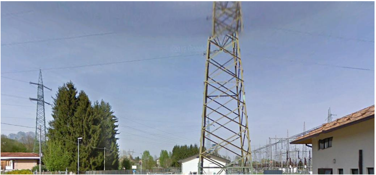
Stazione elettrica di Vellai Feltre (BL)
