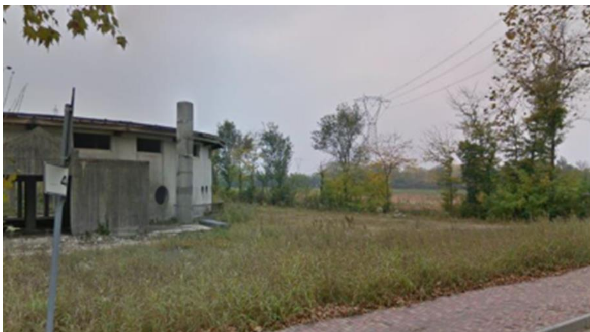
Montebelluna (TV) – Scuola in frazione Busta abbandonata a seguito della realizzazione dell'elettrodotto a 380kV
