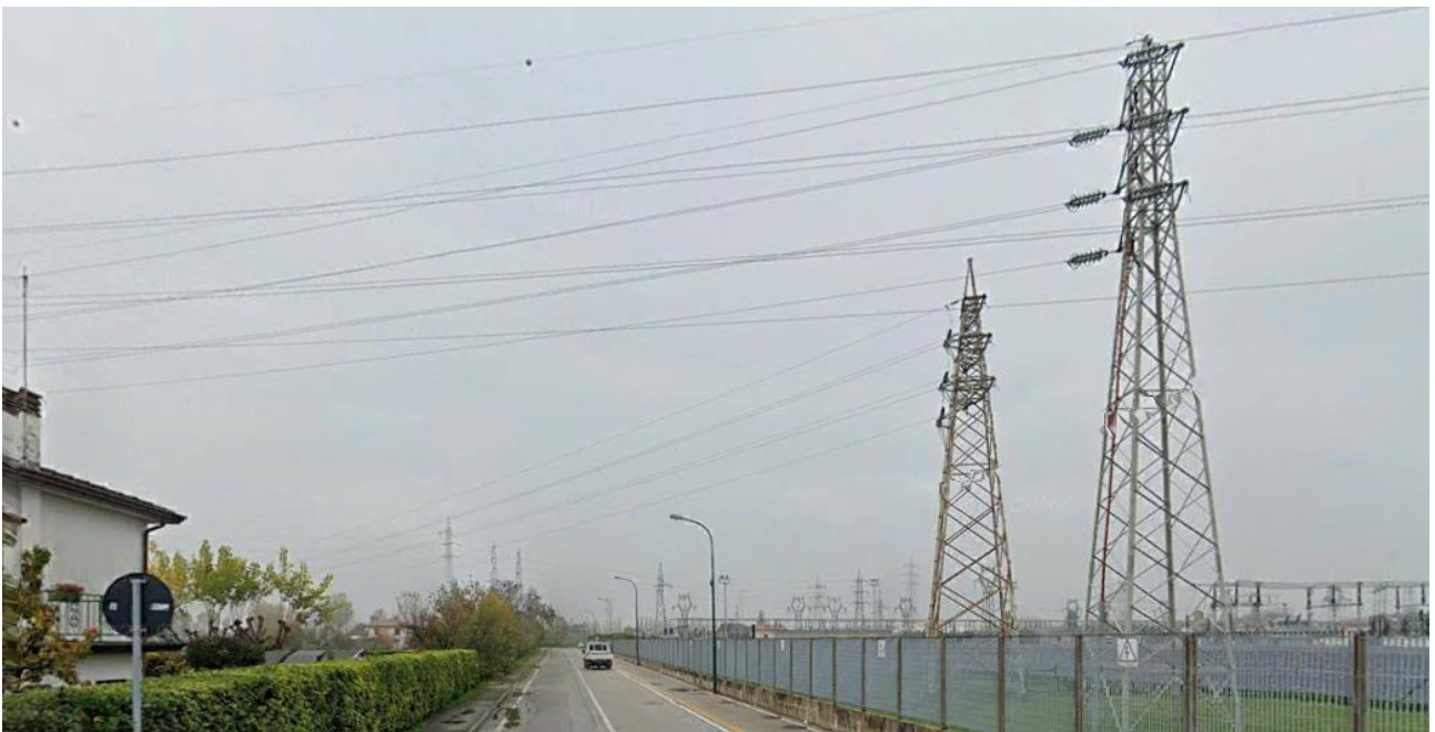
Stazione elettrica di Villa Bona Venezia Mestre
