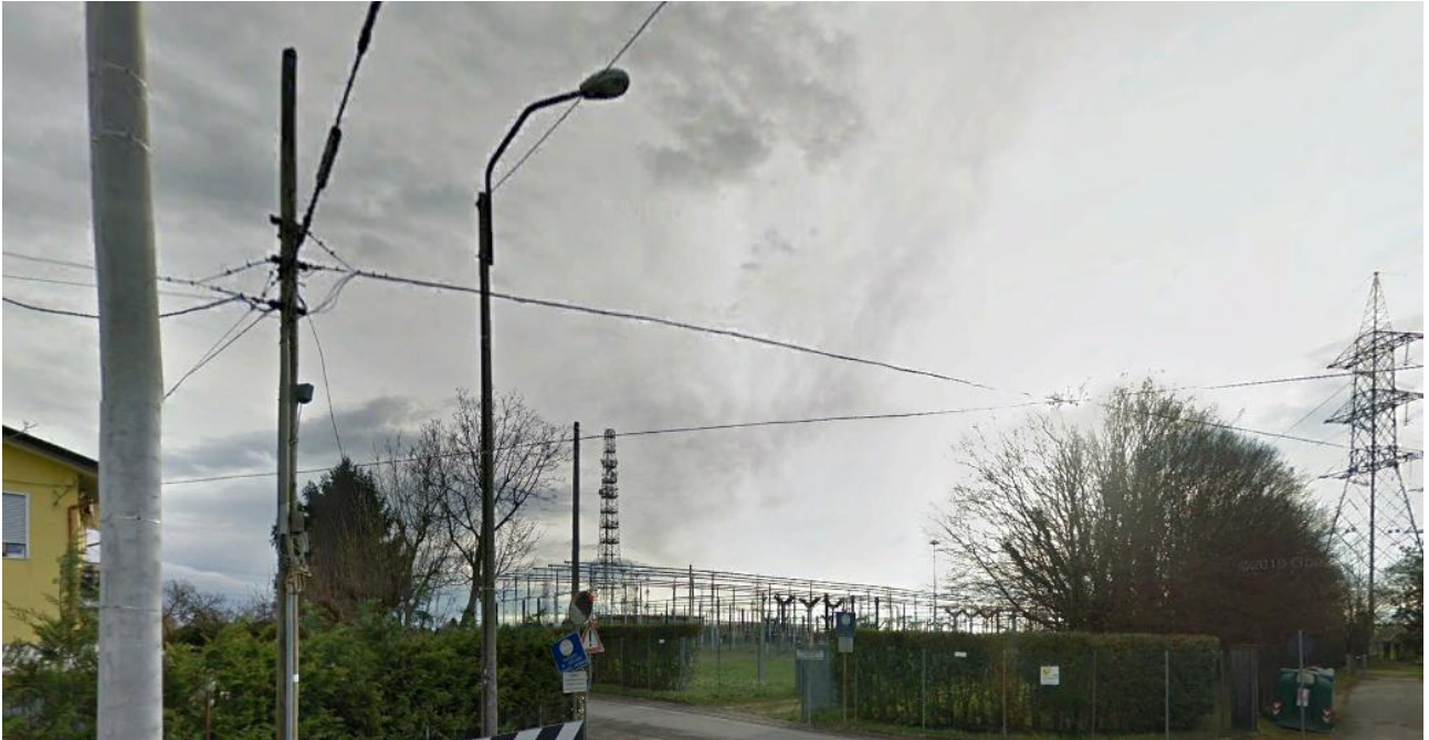
Stazione elettrica di Venezia Nord
