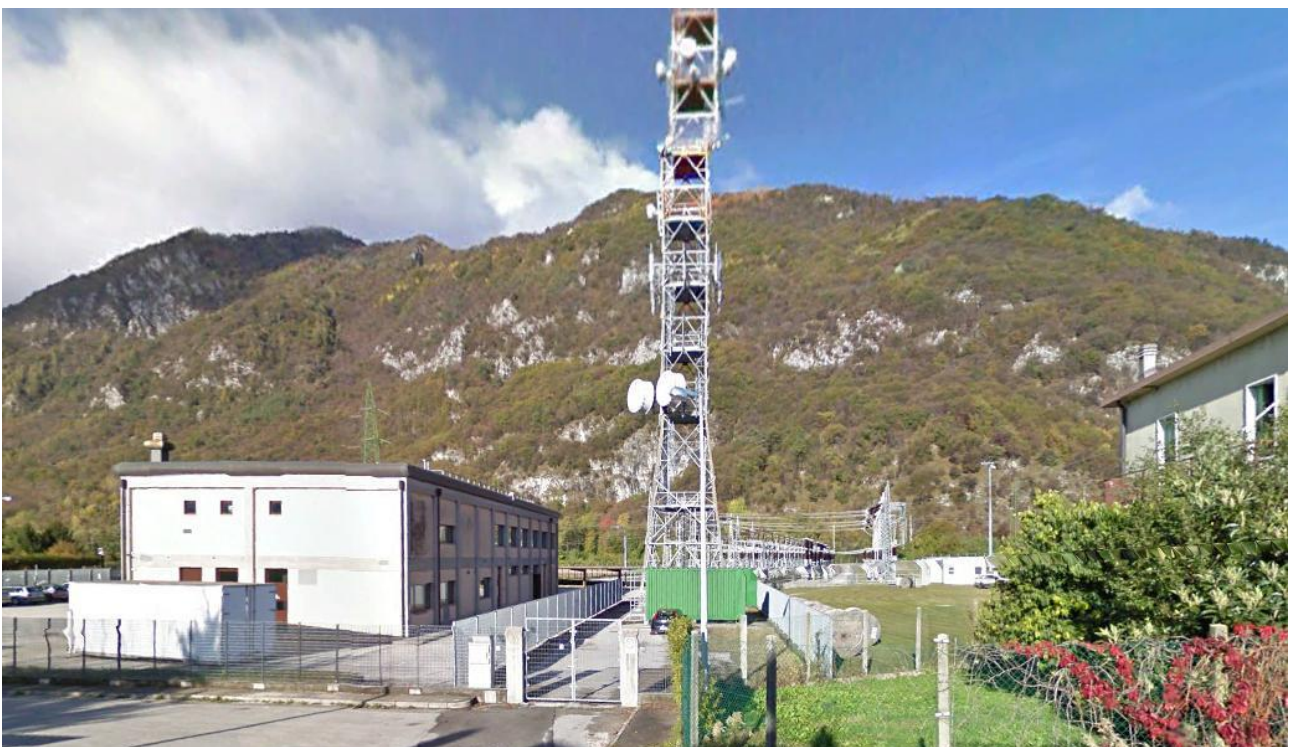
Stazione elettrica di Ponte nelle Alpi (BL)
