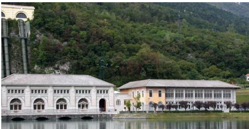
Vittorio Veneto (TV) – centrale elettrica Fadalto 1924
