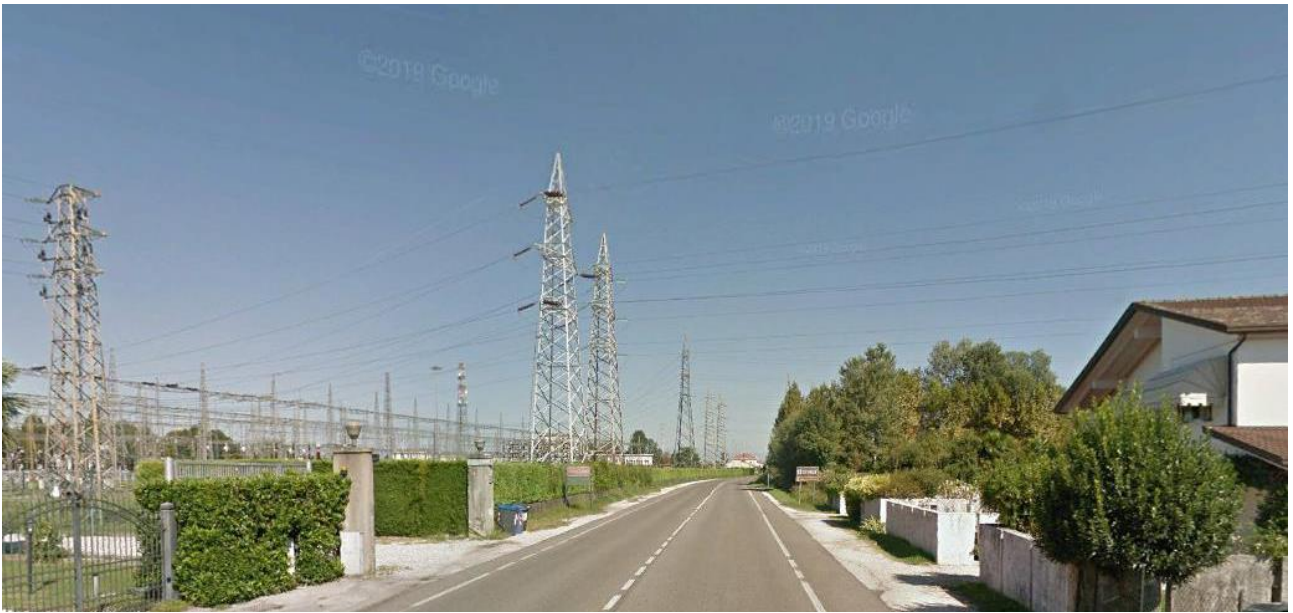
Stazione elettrica di Scorzè (VE)
