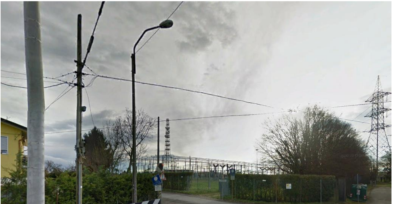
Stazione elettrica di Venezia Nord
