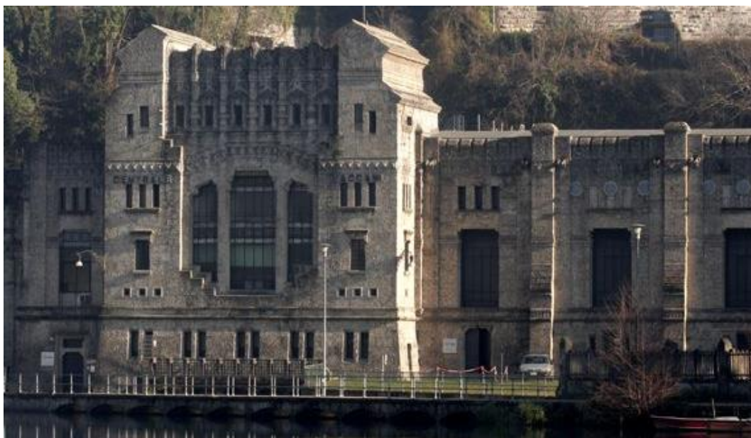
Trezzo sull'Adda (MI) – Centrale elettrica Taccani 1906
