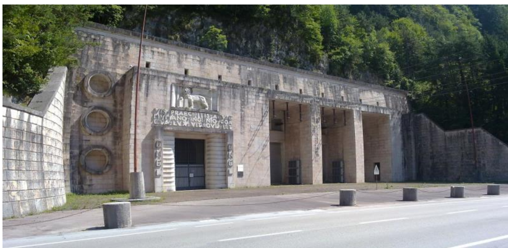
Sedico (BL) - Centrale elettrica la Stanga 1943
