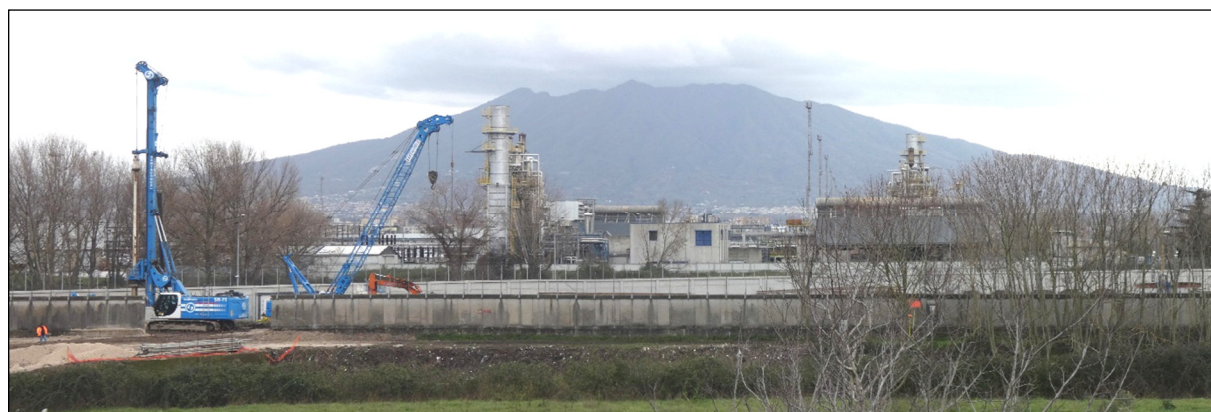
Figura 4.6/6 Cantiere per la realizzazione della linea AV Napoli-Bari ripreso dalla Strada Provinciale Ex S.S. 162 con in secondo piano la centrale
