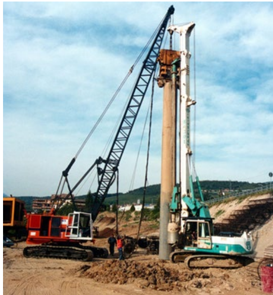
Figura 18 Trivellazione pali
