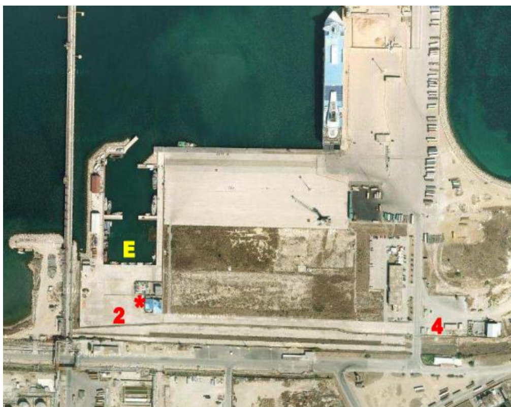
Figura 5-6 Cartina del porto industriale di Porto Torres con indicazione del luogo delle postazioni di misura
