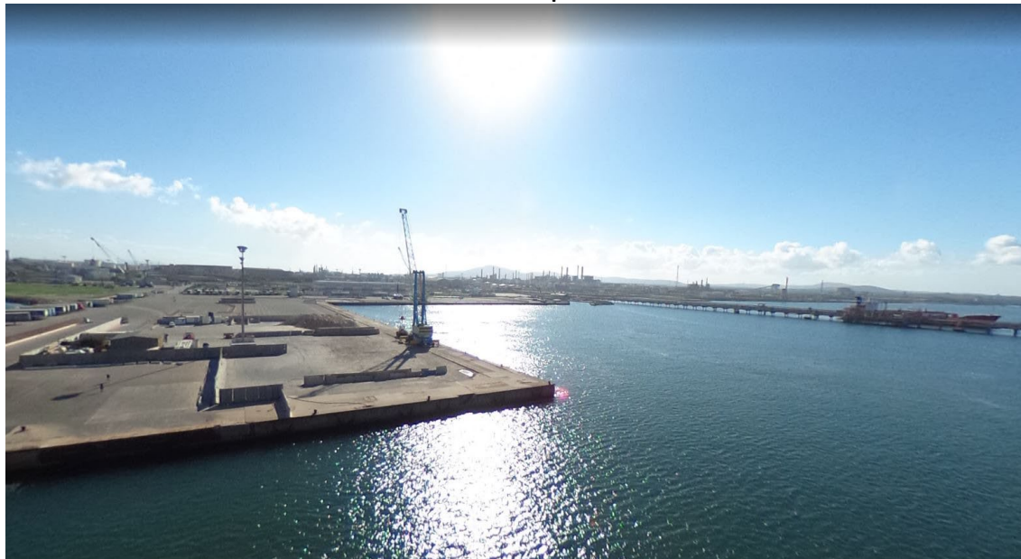
Foto C2 Vista interna del porto
