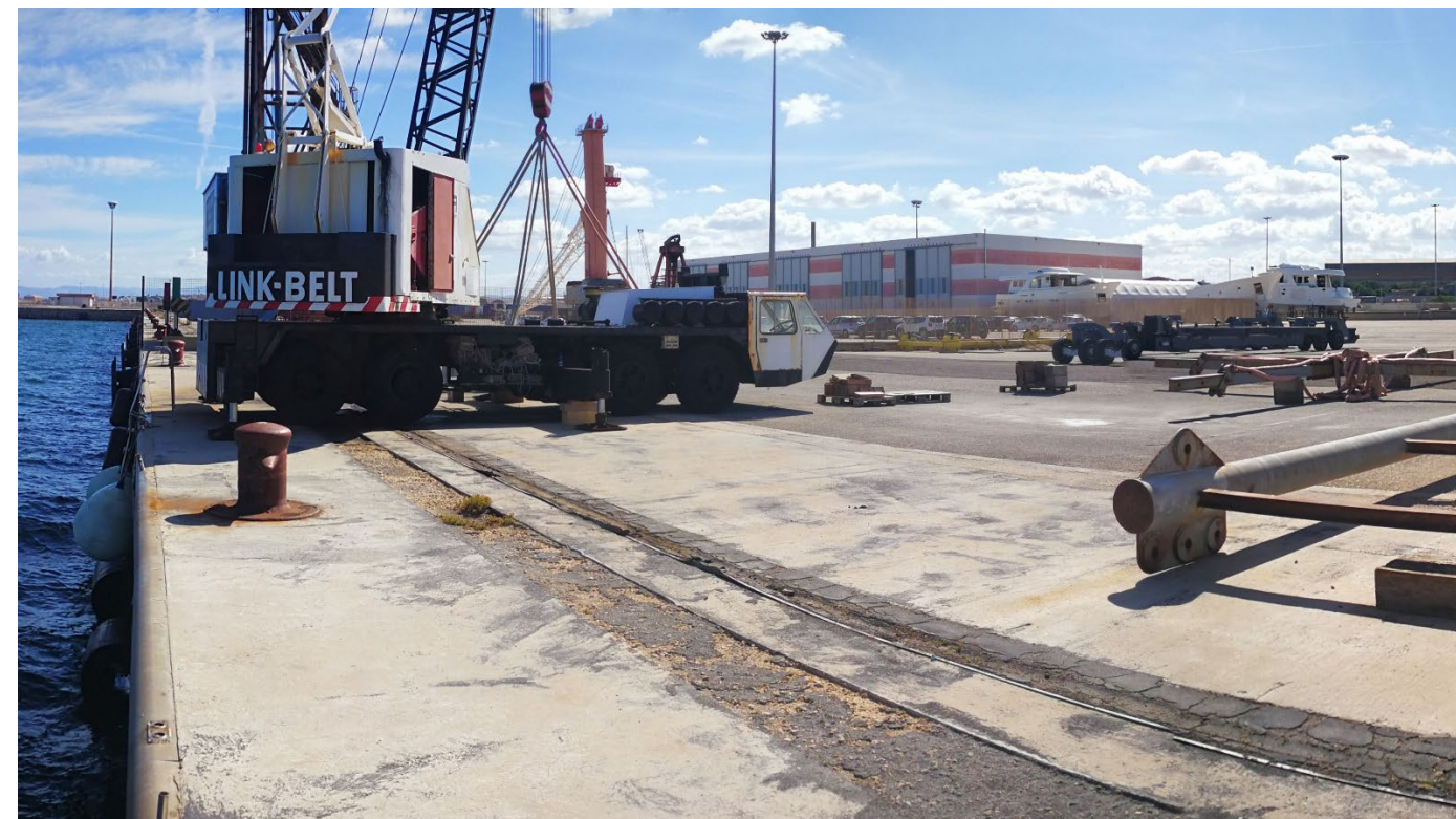
Figura 21 Vista 2 Ante operam
