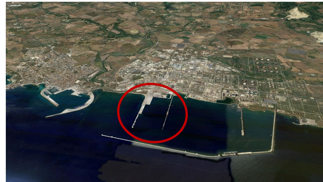
Figura 7 Vista aerea dell'area in studio (da Google Earth)
