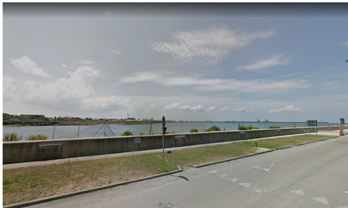
Foto C10 Vista dal porto turistico verso area del porto industriale
