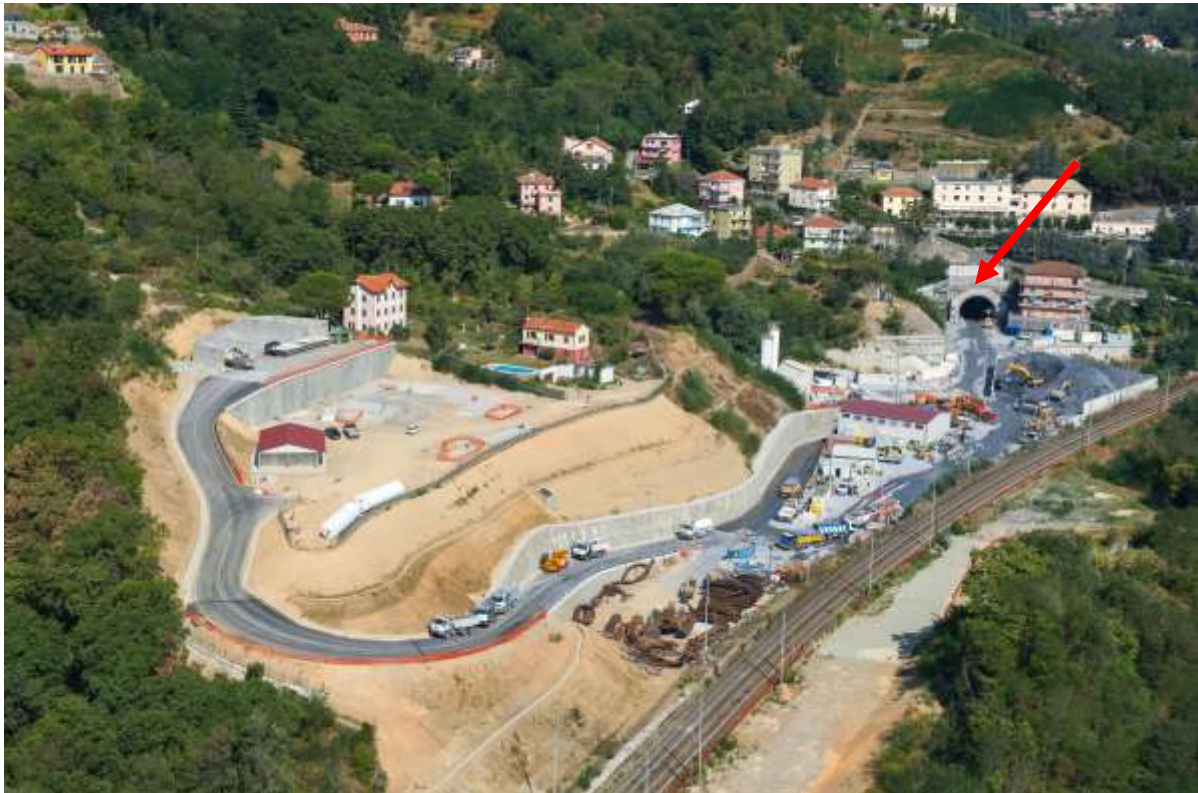
Figura 210 – Foto aerea del cantiere COL2 oggetto degli interventi di cui all’Ambito 1 - Fegino
