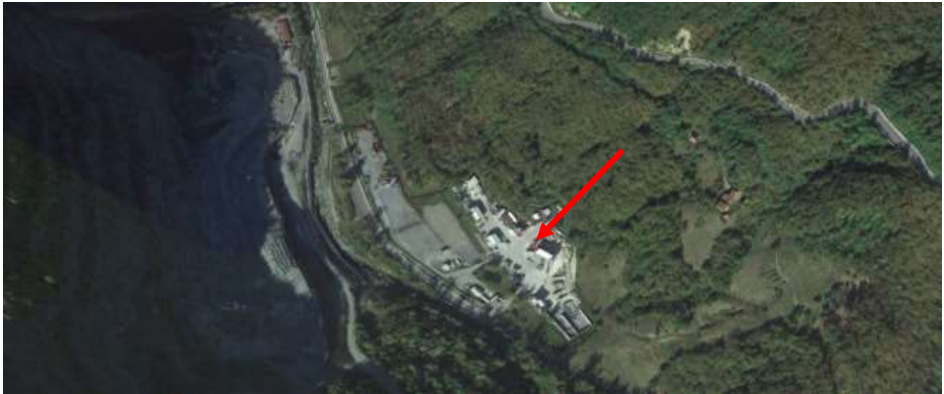
Figura 213 – Foto aerea dell'area del cantiere Vallemme (identificato con freccia rossa) a servizio dell'omologa finestra.
