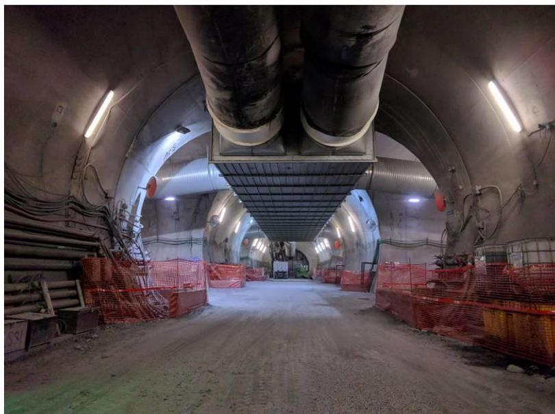
**Figura 4 –Camerone d'innesto Polcevera – Dotazioni impiantistiche relativo al sistema Plenum**
