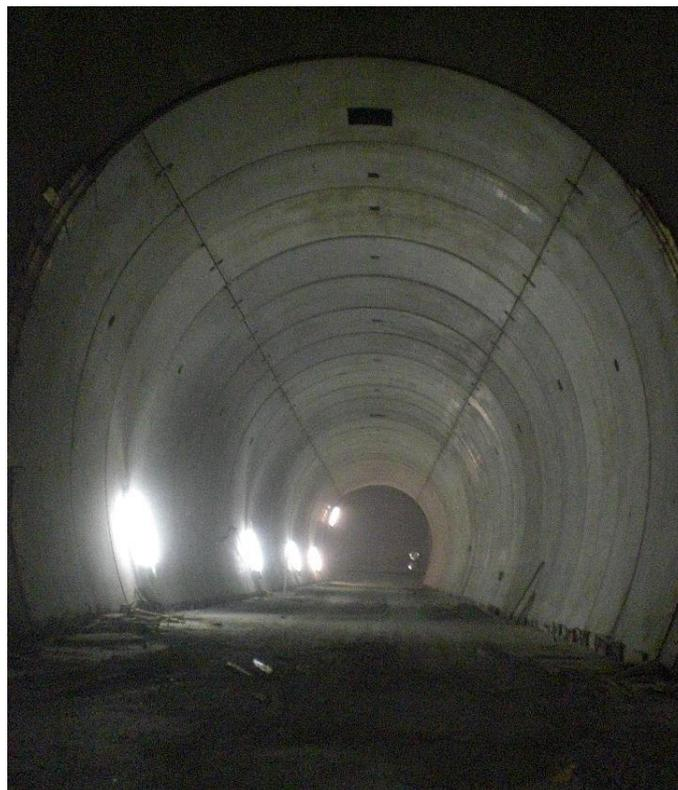
**Figura 2 – Esempio di conci autoportanti in c.a.v. posati in opera**
