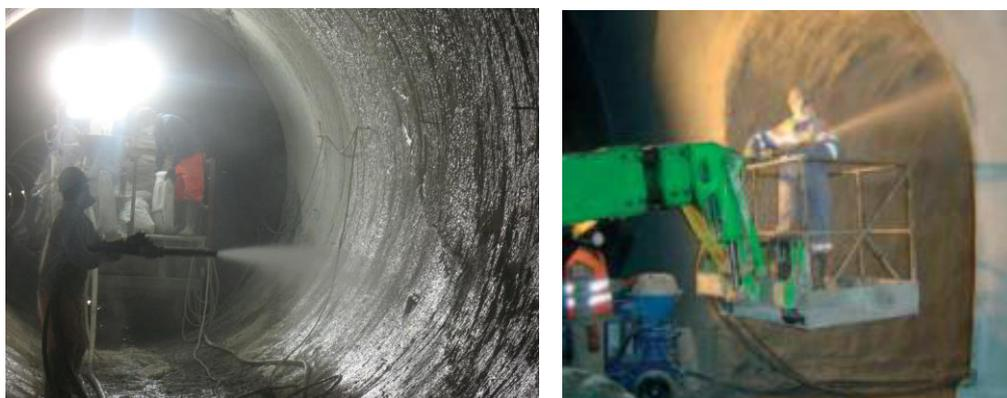
**Figura 7 - Posa in opera in sezione di ridotte dimensioni (a) ed in un by-pass**
